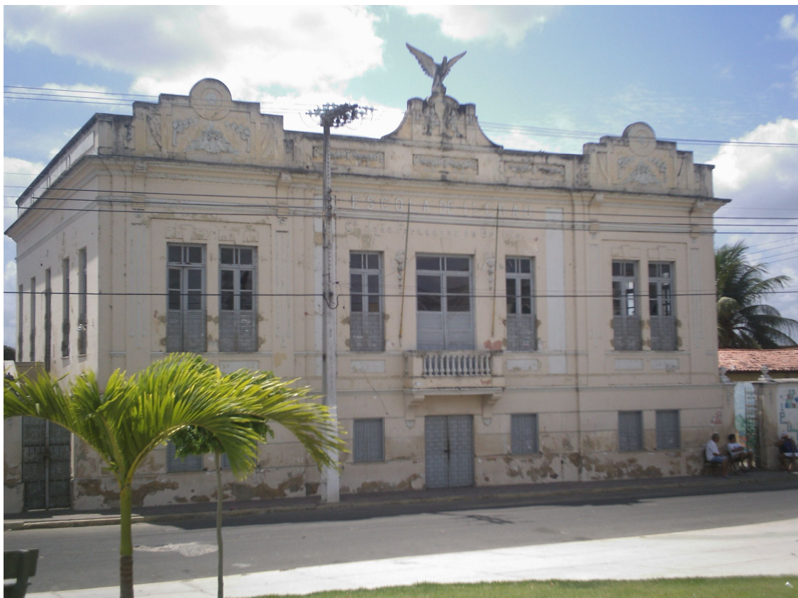
Foto 1: Fachada da Escola Estadual Cel. João Fernandes de Britto.
