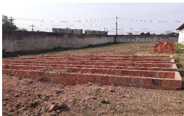
Figura 13 - Espaço em construção para a horta
