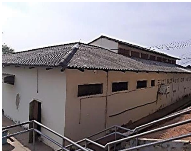
Figura 16 - Visão da área externa dos alojamentos/celas pavilhão A e B
