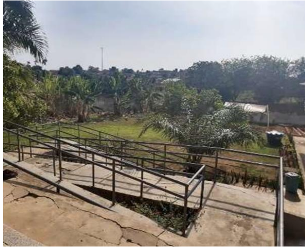
Figura 14 - Rampa de acesso ao espaço da horta em construção
