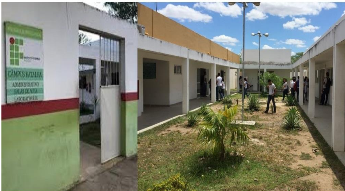
Figura 14 – Instituto Federal de Alagoas, campus Batalha.
