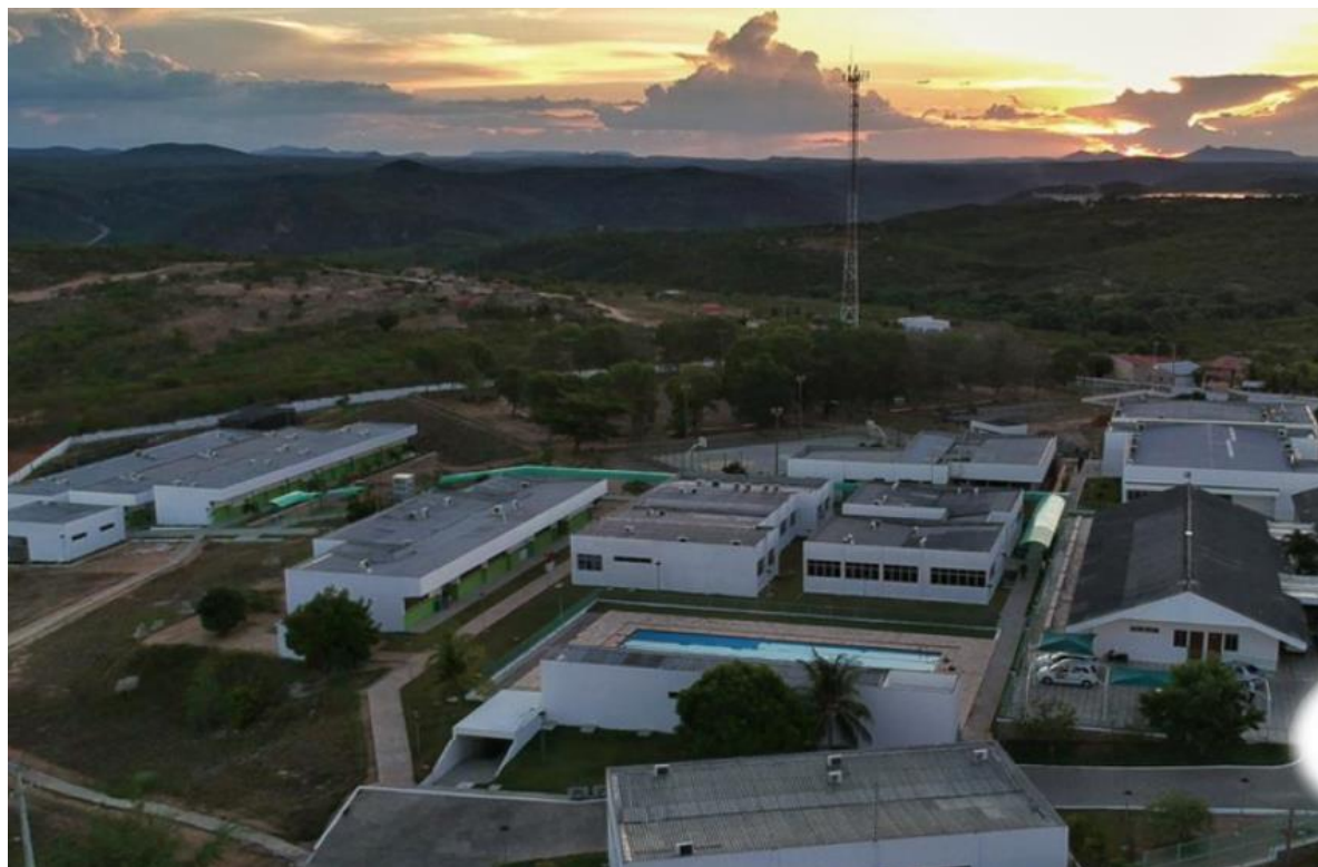
Figura 12 – Instituto Federal de Alagoas, campus Piranhas.
