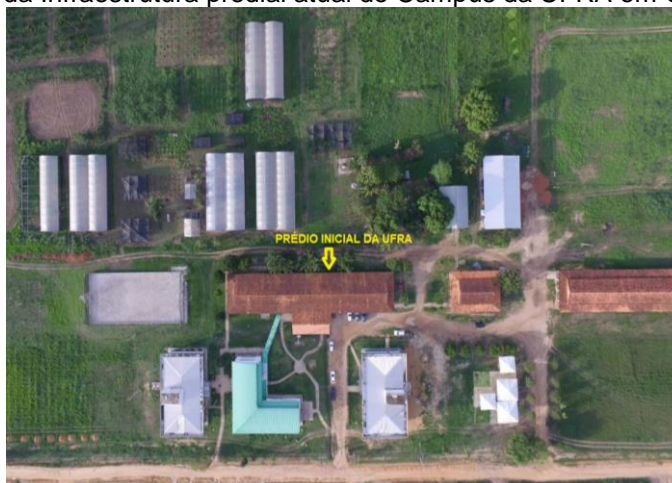
Figura 08: Vista aérea da Infraestrutura predial atual do Campus da UFRA em Capitão Poço.
