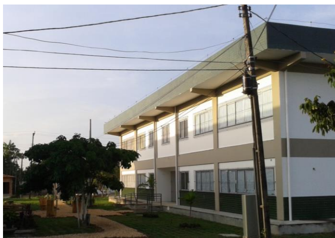
Figura 09: Pavilhão de aulas da Licenciatura em Computação no Campus da UFRA em Capitão Poço
