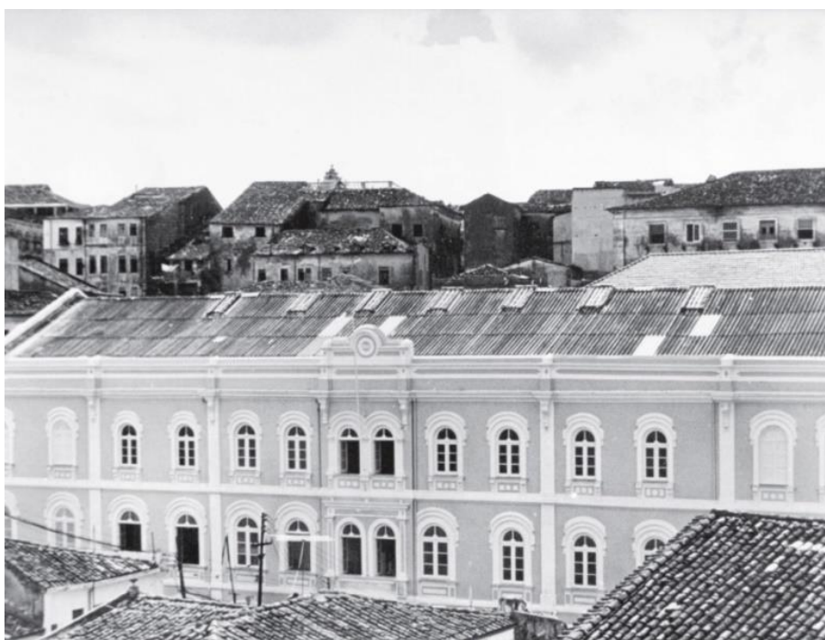
Figura 32 - Prédio “Jonathas Abott”, sede da Escola de Belas Artes (EBA)-1960
