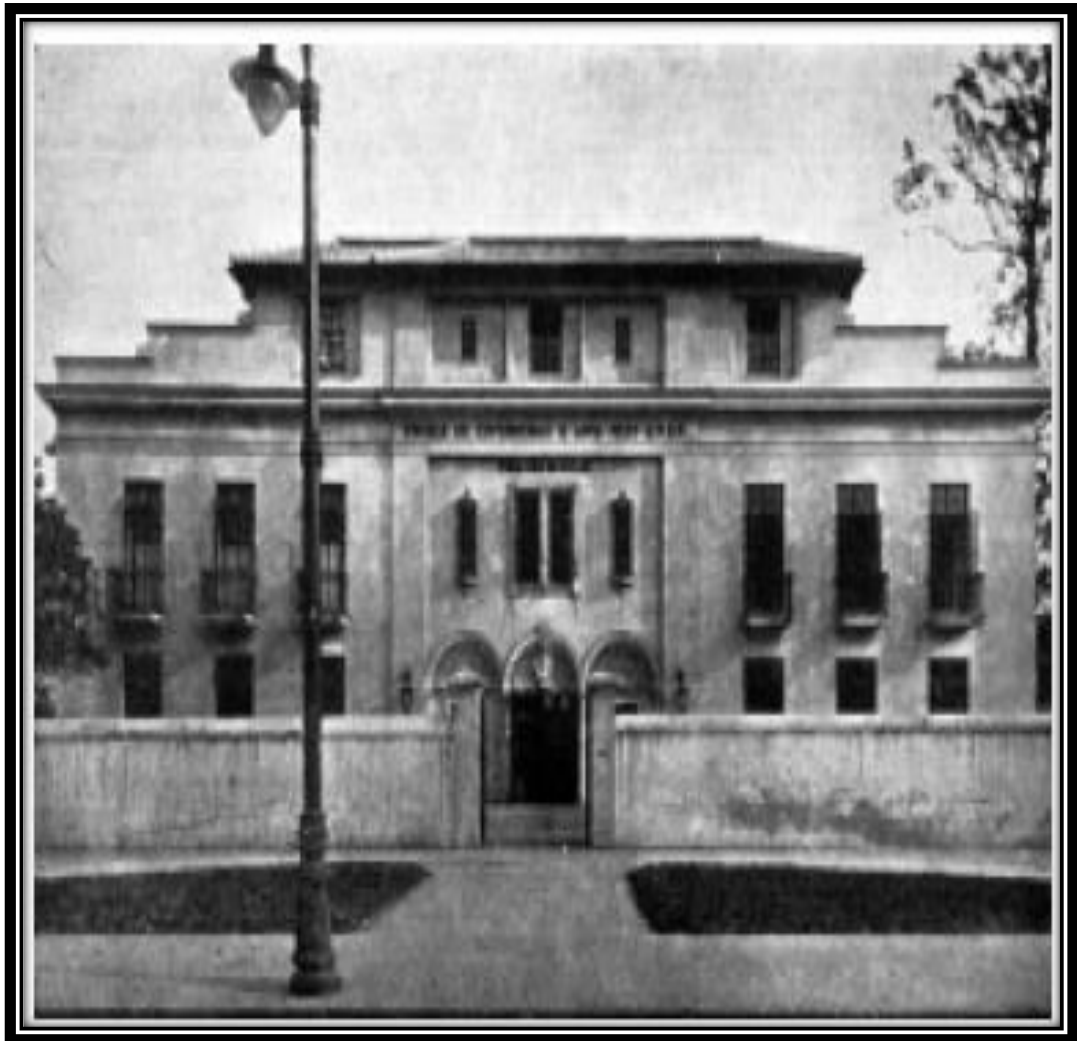
Figura 31- Pavilhão de Aulas da Escola de Enfermagem Anna Nery.
