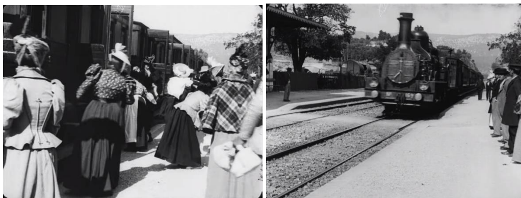
Figura 11 e 12 – Registro da chegada do trem na estação (1896) / Fonte: YouTube (2017)
