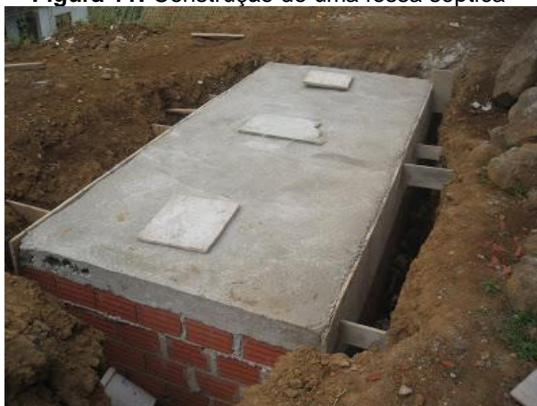
Figura 11: Construção de uma fossa séptica
