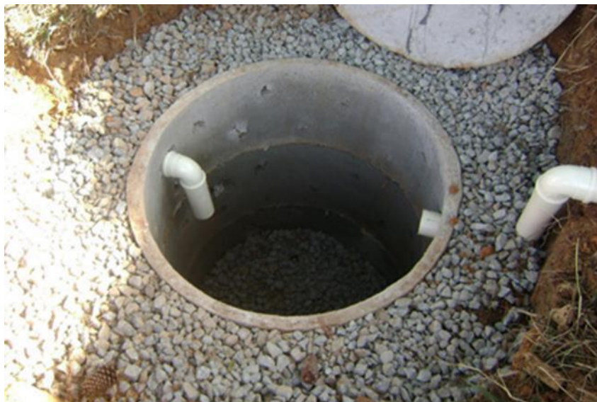
Figura 13: Sumidouro construído de anel-moldado de concreto com fundo preenchido de brita
