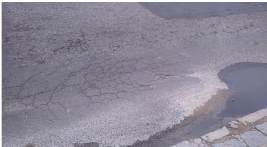
Figura 9.1: Couro de Jacaré sem erosão
