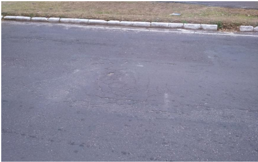
Figura 9: Couro de Jacaré com erosão
