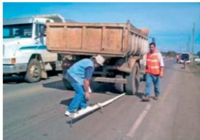
Figura 3.2: Medição com Viga Benkelman em campo
