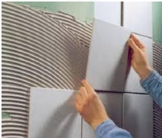
Figura 32 – Aplicação de revestimento cerâmico.
