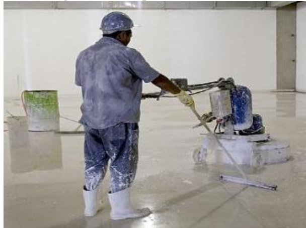
Figura 33 - Limpeza do revestimento
