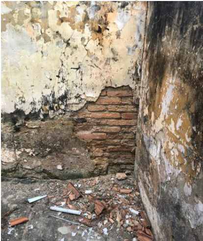
Figura 5 - Parede degradada.
