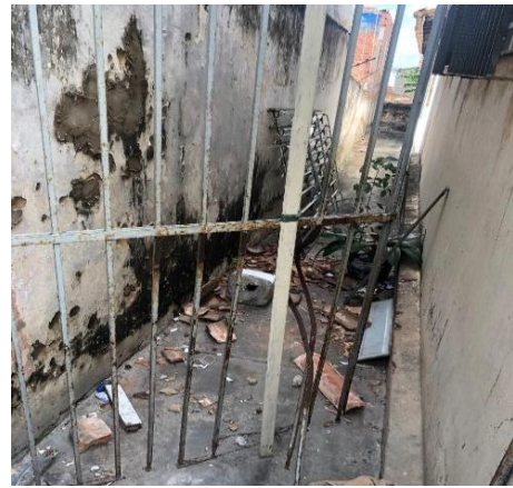
Figura 20 - Porta da circulação lateral externa.
