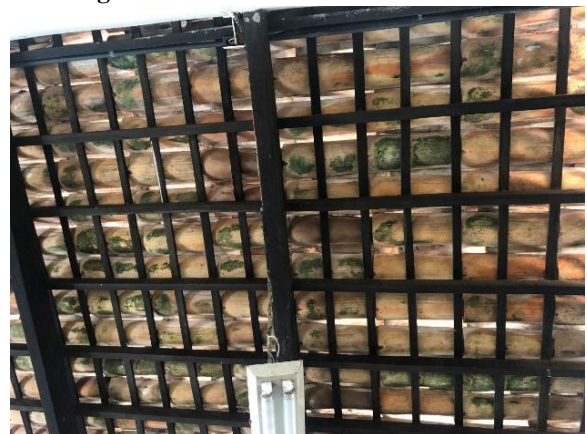
Figura 22 - Parte interna da cobertura.
