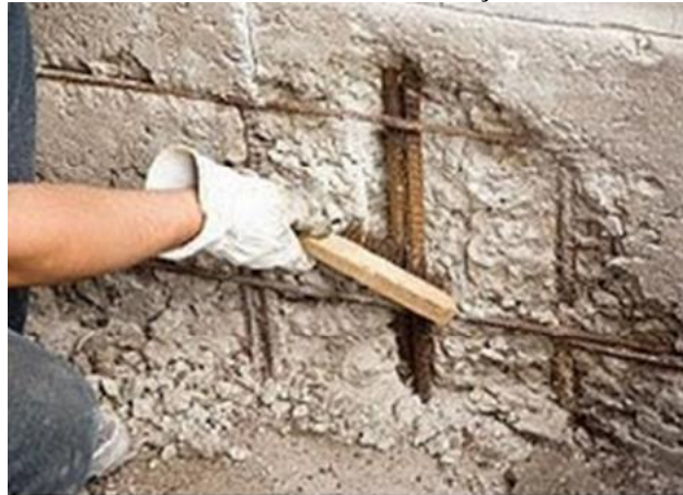
Figura 30 - Remoção de produtos da corrosão com escova com cerdas de aço
