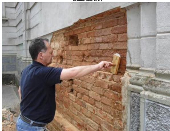
Figura 29 - Aplicação do silicato, bloqueador de umidade.
