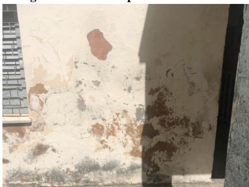
Figura 27 - Parede próxima às escadas
