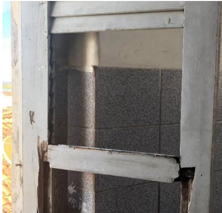
Figura 19 - Janela de madeira na sala de aula.
