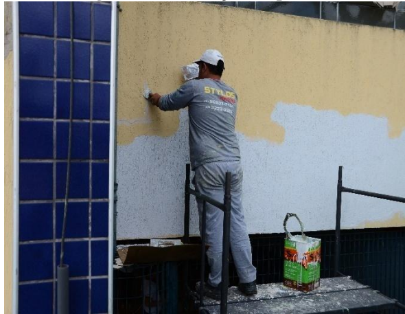
Figura 40 – Execução de pintura
