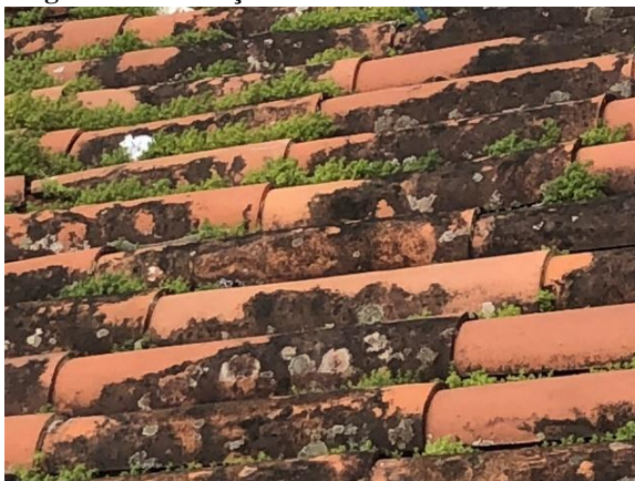
Figura 21 - Situação da cobertura vista de cima.
