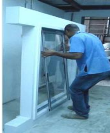
Figura 36- Instalação de novas janelas.
