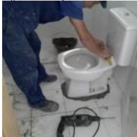
Figura 39 – Fixação de bacia sanitária.
