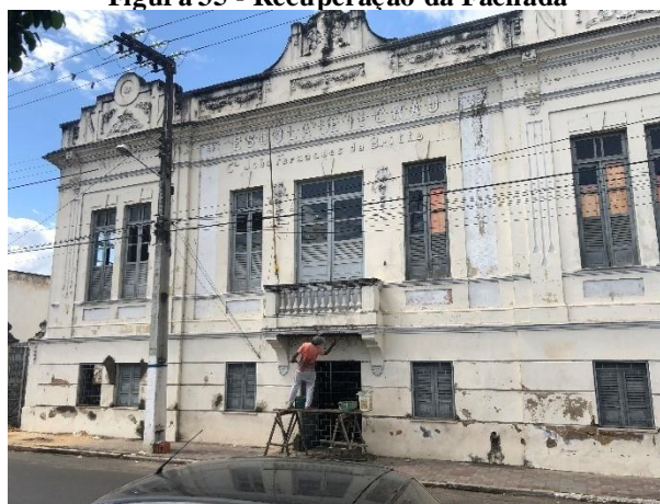
Figura 35 - Recuperação da Fachada
