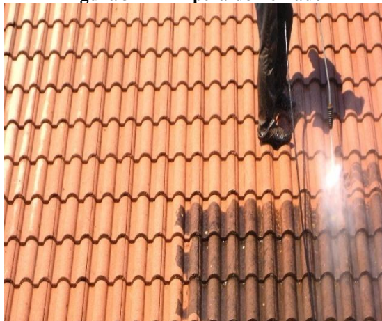
Figura 37 – Limpeza do Telhado
