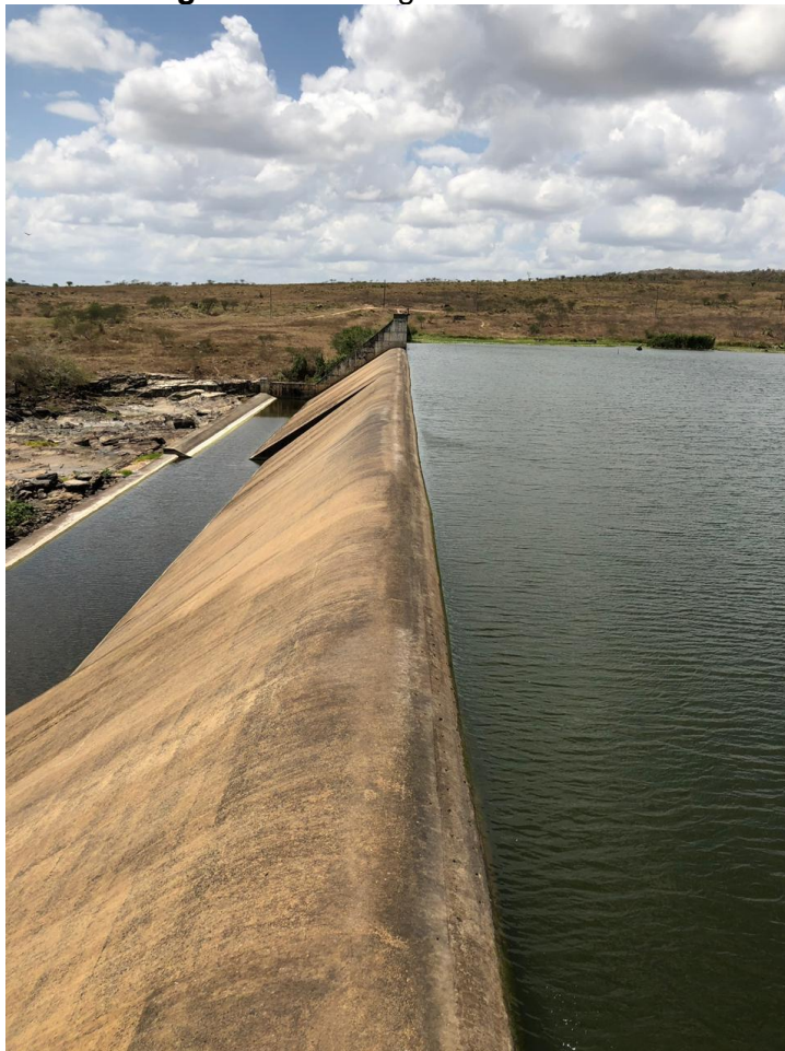
Figura 30 - Barragem do Rio Piauí.
