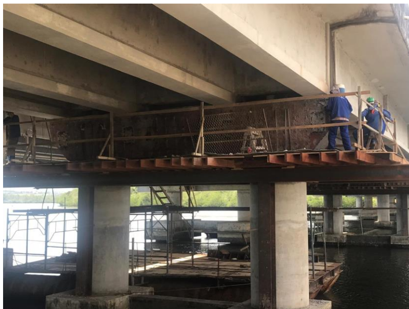
Figura: Colocação das presilhas para a armadura Fonte: Arquivo pessoal 2018
