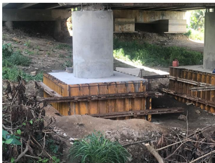
Figura 38: Conclusão do reforço no pilar
