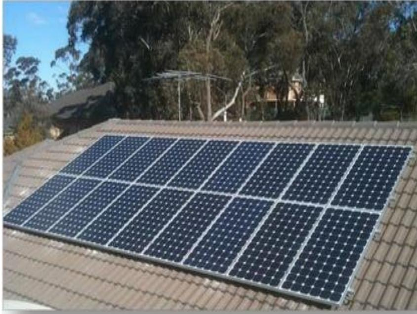
**Figura 16:** Módulos fotovoltaico 24 V, sistema autônomo.
