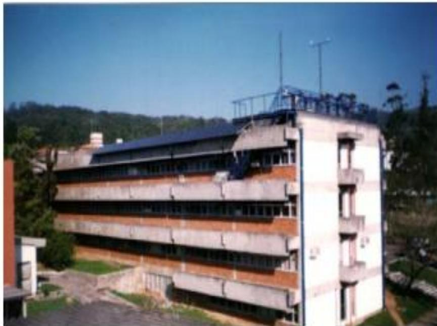
**Figura 5:** Primeira instalação solar fotovoltaica integrada a uma edificação urbana e ligada à rede elétrica no prédio da Universidade Federal de Santa Catarina.
