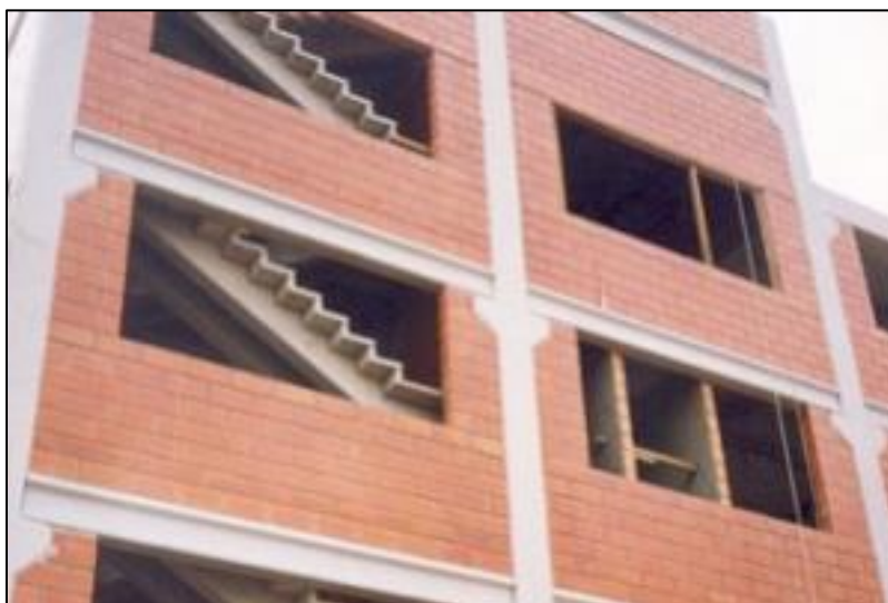
Figura 3 – Alvenaria de Vedação Racionalizada
