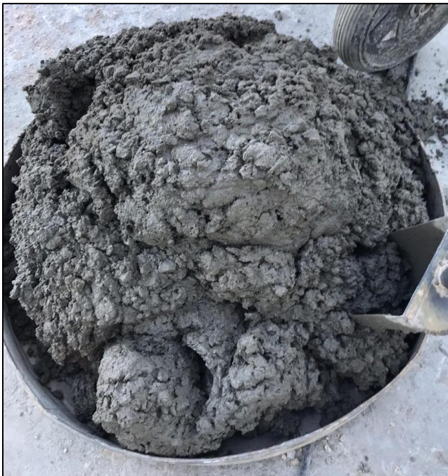
Figura 37 - Concreto preparado sendo reservado na fôrma
