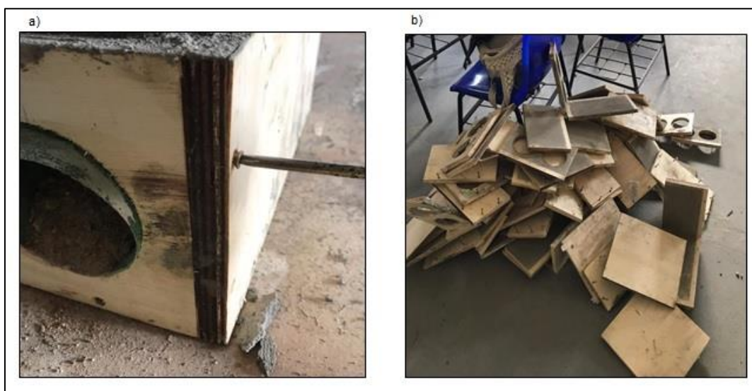
Figura 46 – (a) Desmolde da fôrma com chave de fenda, (b) Fôrmas de madeiras sendo separadas
