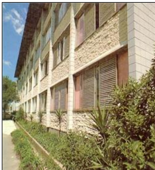
Figura 1 – Conjunto Habitacional Centro Parque Lapa
