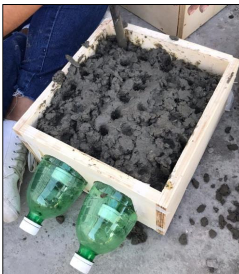
Figura 40– Segunda camada de concreto com a colocação das garrafas PET
