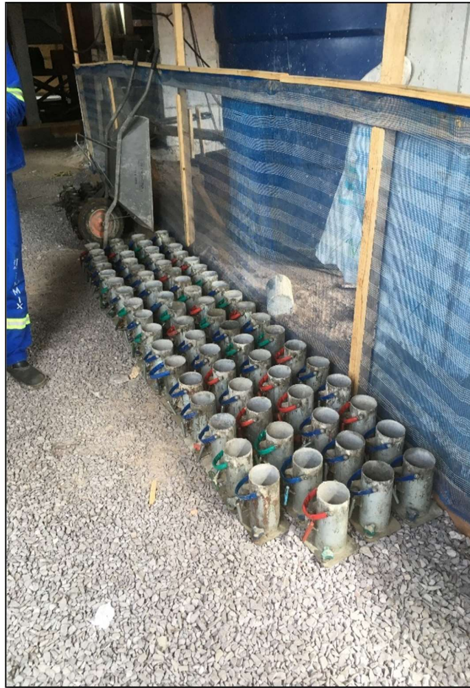
Figura 15 - Formas para moldagem dos corpos de prova.
