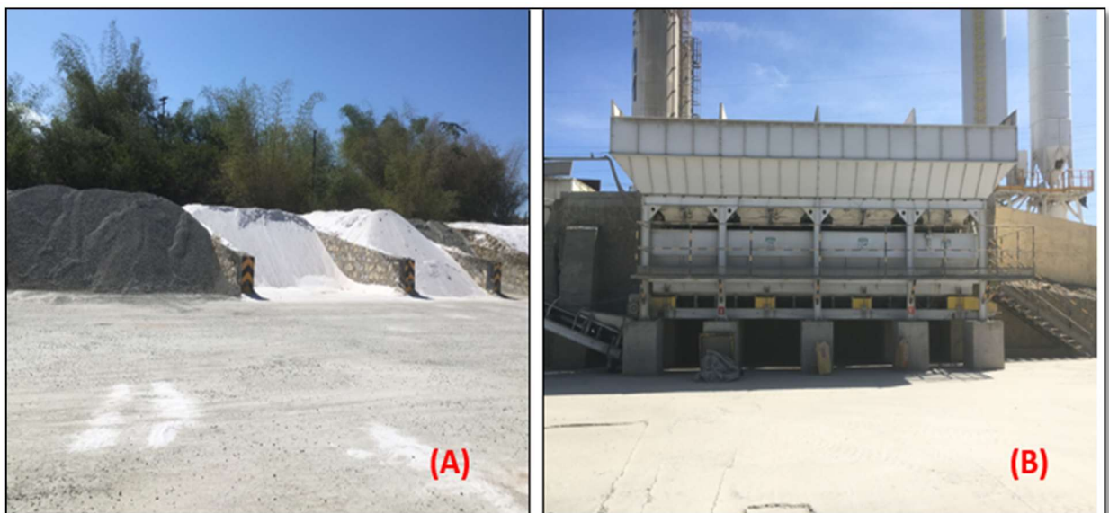
Figura 11 - (A) Baias para separação dos agregados. (B) Dosagem dos agregados.
