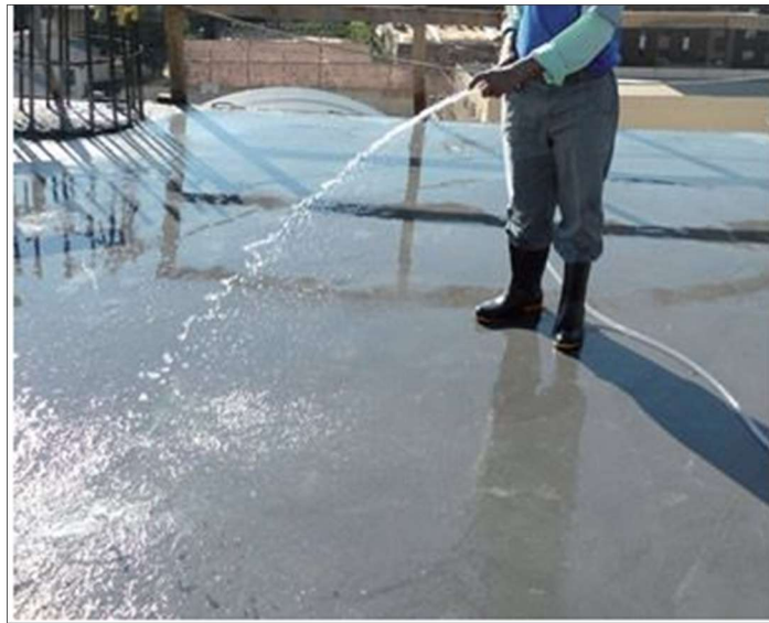
Figura 9 - Molhagem do concreto recém lançado.
