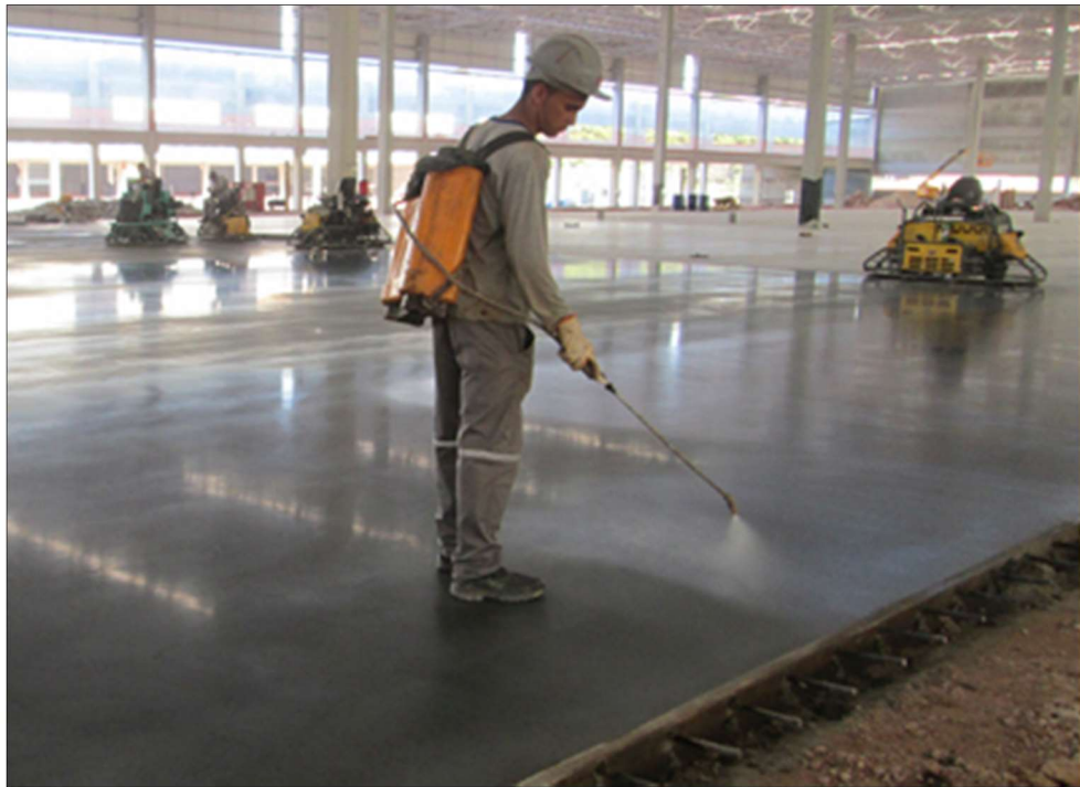
Figura 10 – Aplicação da cura química.
