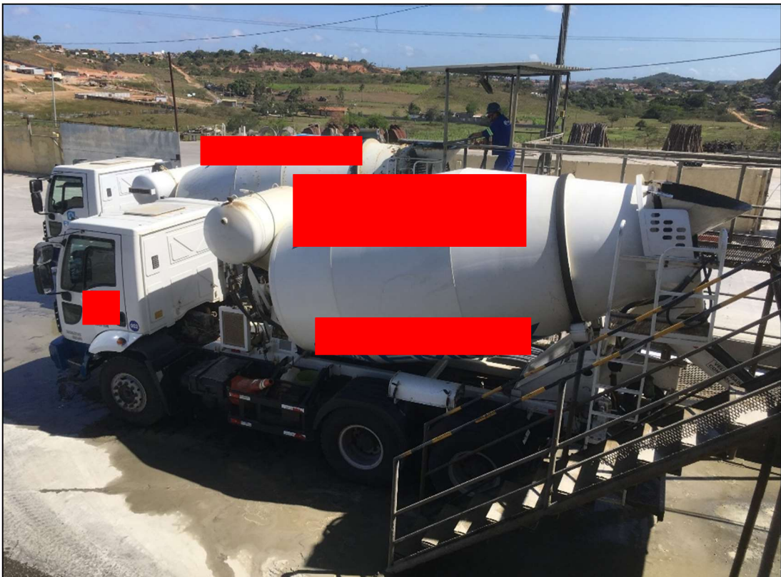
Figura 12 – Caminhão betoneira para mistura e transporte do concreto.
