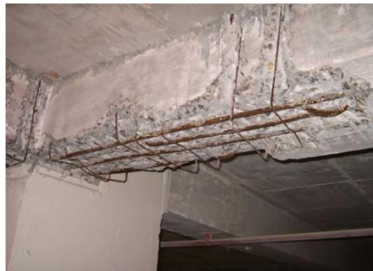
Figura 4: Corrosão em pilar
