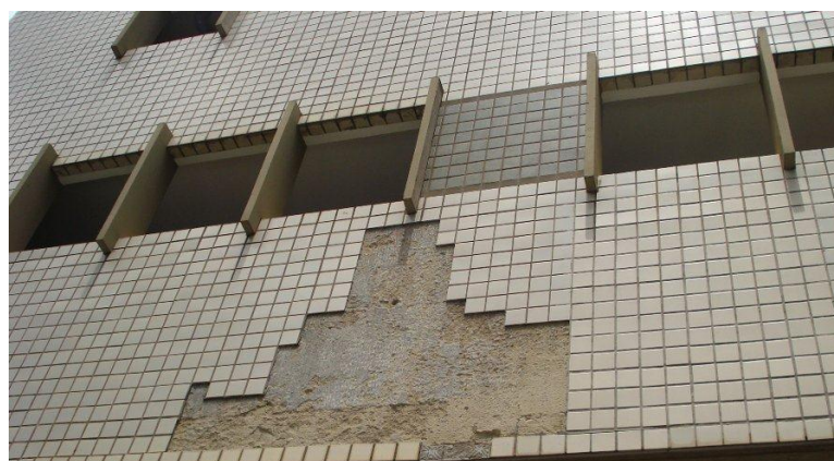
Figura 12: Destacamento cerâmico Fonte: Habitíssimo(2009)
