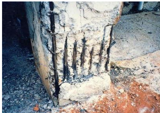
Figura 4: Corrosão em pilar
