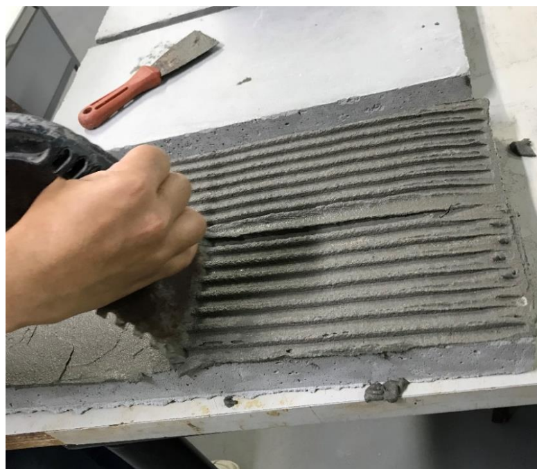
Figura 18: Formação dos cordões de argamassa.
