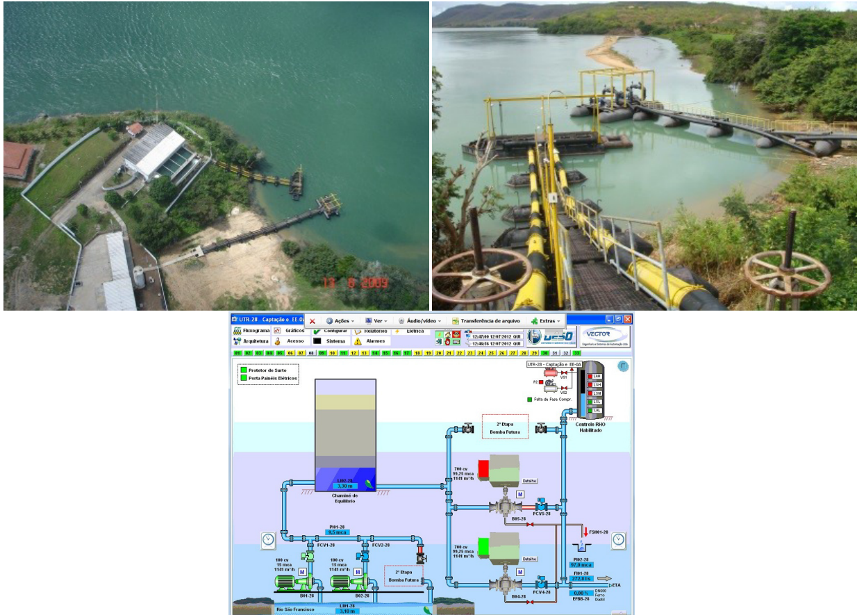
Figura 14 – Vista área, captação concluída e painel de automação.
