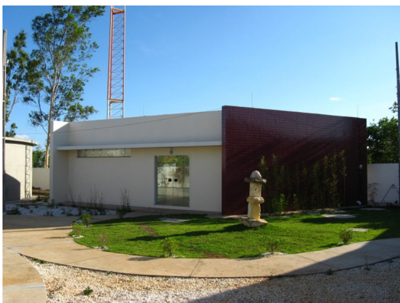
Figura 9 – Centro de Controle Operacional: vista exterior
