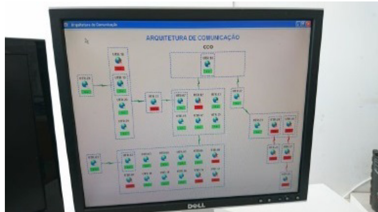
Figura 12 - Supervisório do CCO e status das Áreas
