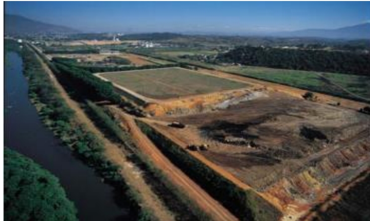
Figura 20: Aterro Industrial Classe I.
