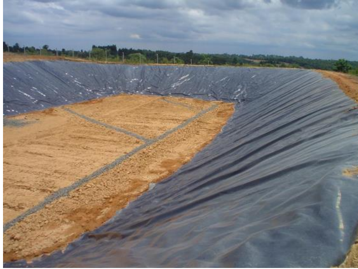
Figura 21: Aterro sanitário em construção. Fonte: (BIDONE, 1999).
