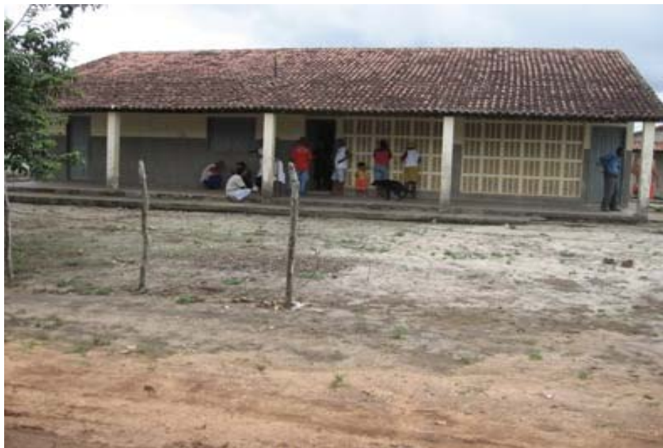
Foto 06 – Centro Comunitário do Assentamento Oito de Março
