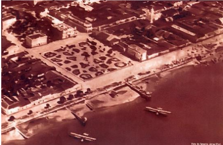
Figura 02 Aspecto da margem direita do rio Sergipe
