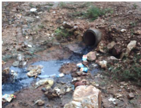
Descrição: Tubulação jorrando chorume. FONTE: Kátia Cristina T. Mendonça
