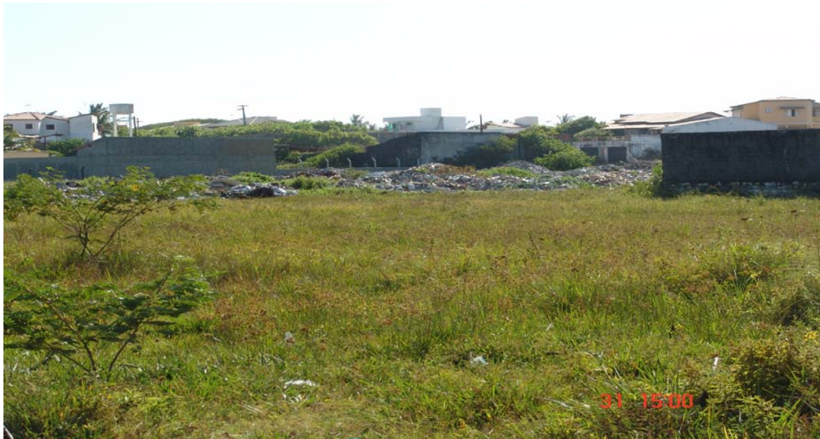
Foto 12: Processo de Aterramento
