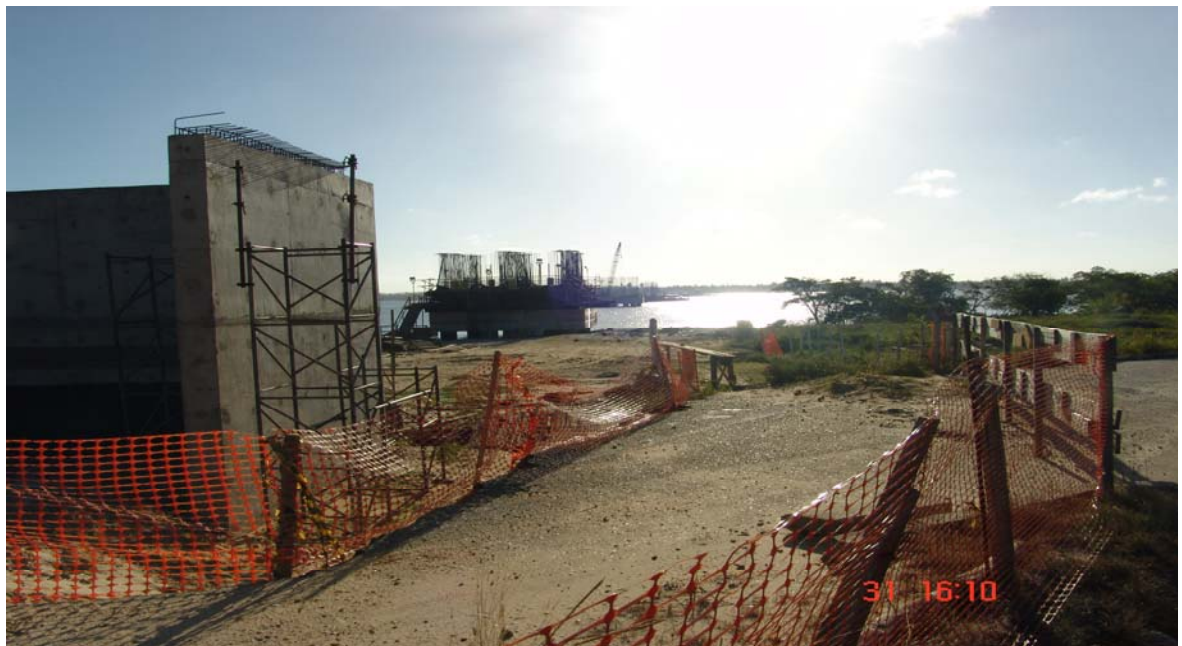
Foto 18: Construção da Ponte sobre o Rio Vaza-Barris
