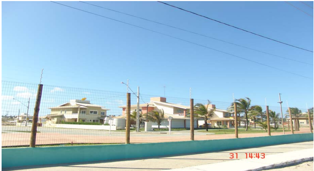
Foto 09: Estrutura do Condomínio Horizontal Fechado
