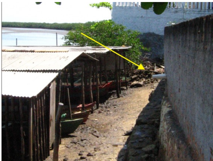
Figura 21: Esgotamento sanitário lançado na área de atracadouro dos pescadores, 2008.
