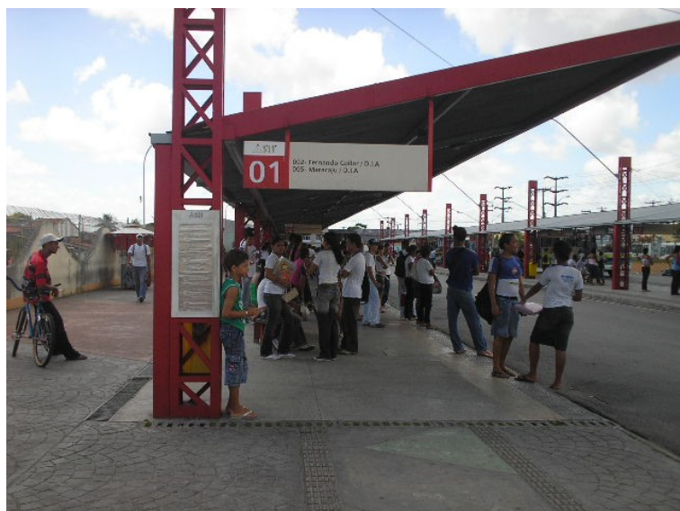
Foto 9 – Terminal do Maracaju recém reformado
