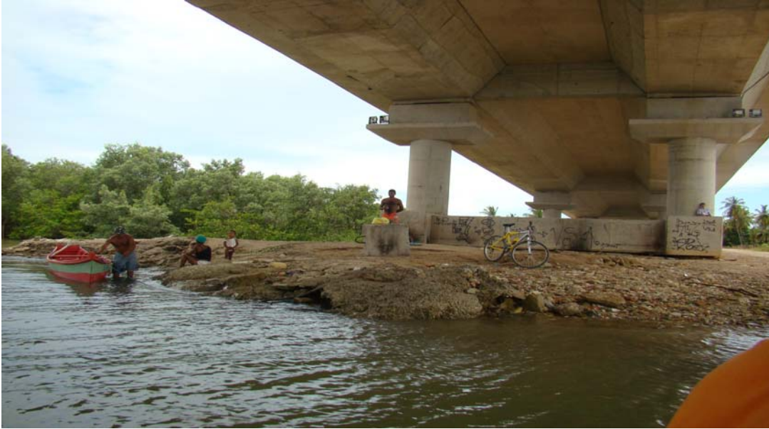
Cabeceira da ponte no município de Barra dos Coqueiros. FOTO: Liliane Pinto.
