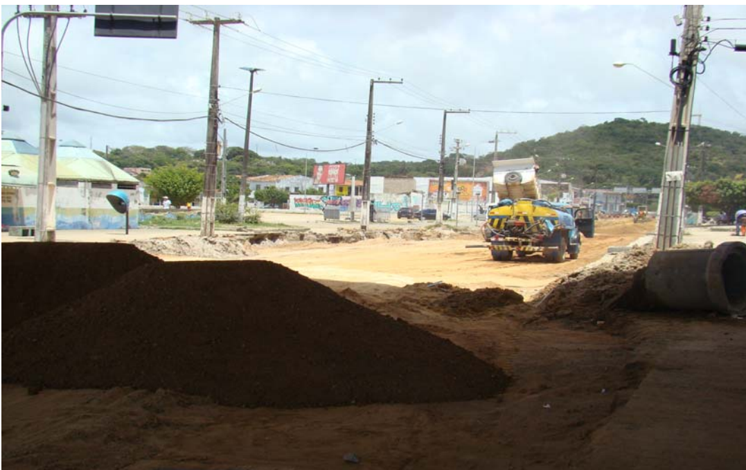
Obras de infra-estrutura nas ruas do bairro Industrial próximas a ponte Construtor João Alves. FOTO: Liliane Pinto.
