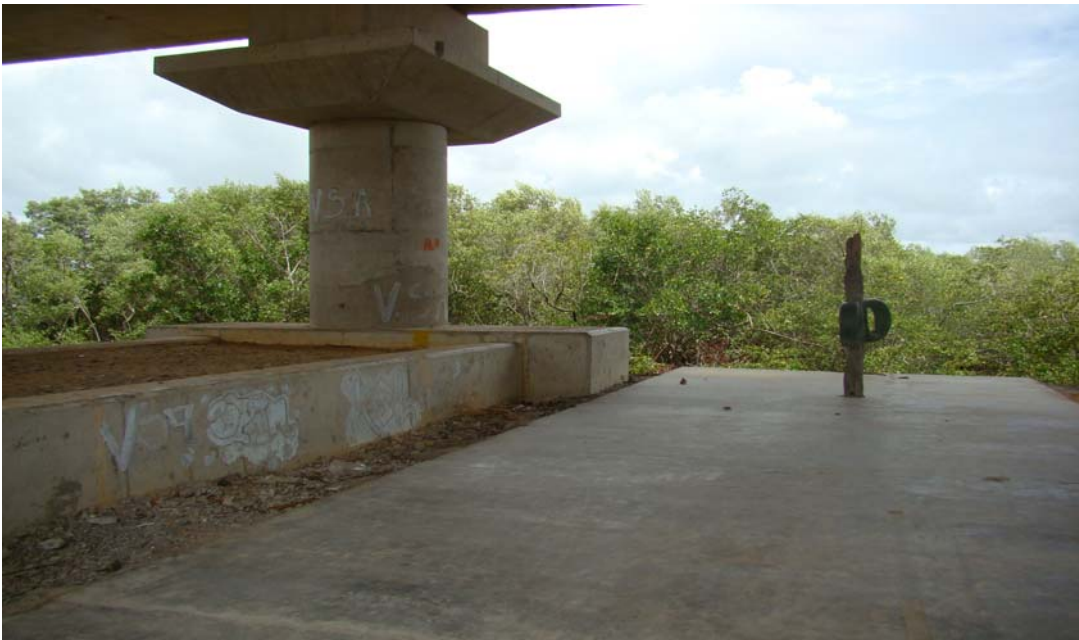
Área embaixo da cabeceira da ponte no município da Barra dos Coqueiros. FOTO: Ester Maria.
