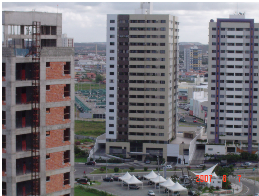
Figura 11: A cada momento surge uma nova construção
