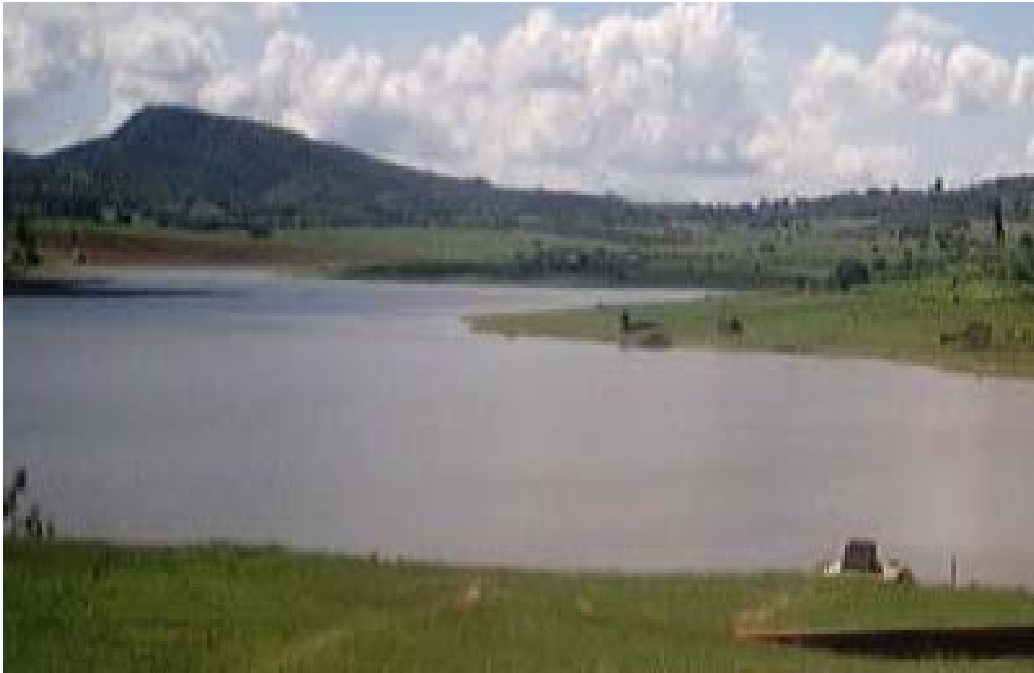
Foto 1 – Barragem da Agrovila
