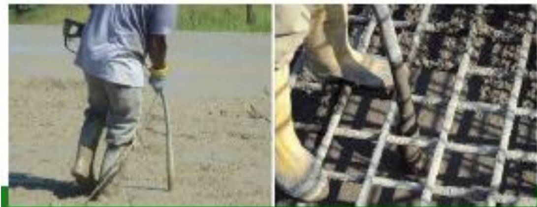
Figura 12: Adensamento com Vibrador. Fonte: EFFTING
