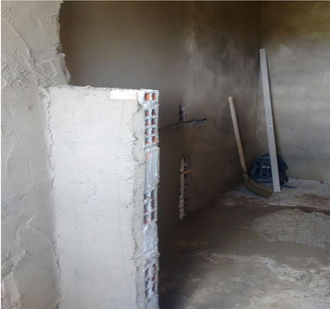
Figura 23: Reboco da Parede Fonte: Tirada pelo Autor
