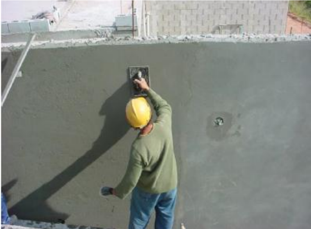
Figura 16: Parede Rebocada. Fonte: CORRÊA
