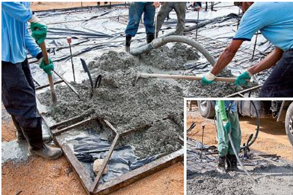
Figura 02: Concretagem do Radier Fonte: LIMA
