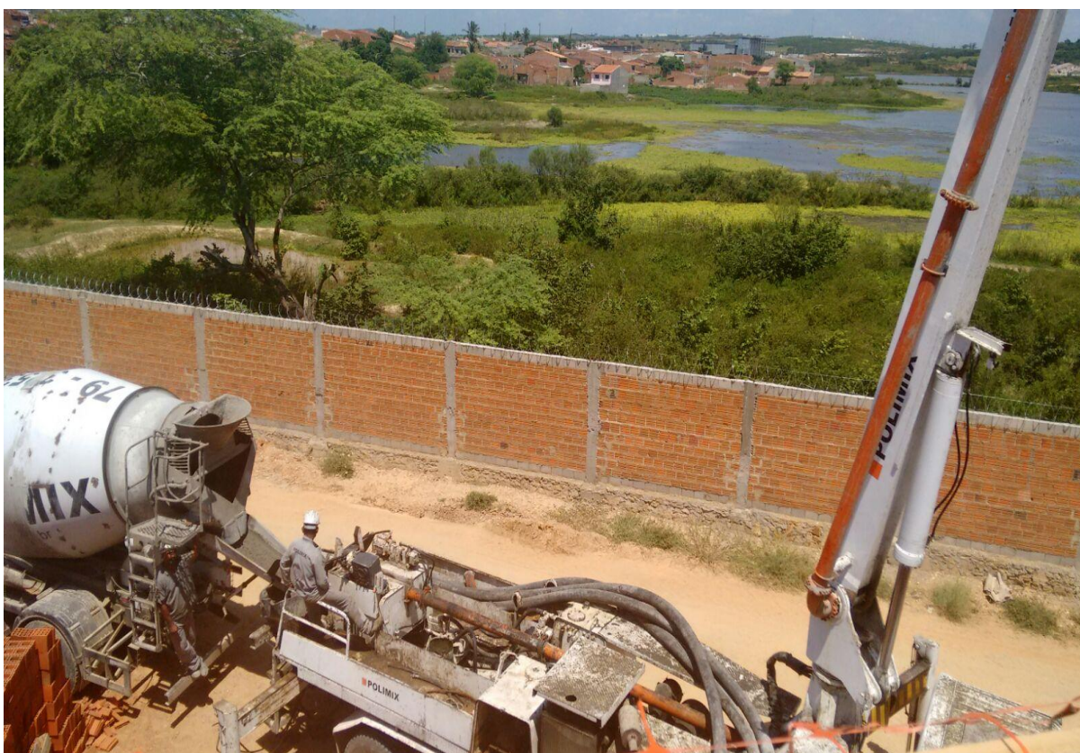
Figura 19: Caminhão Betoneira Pronto para Concretagem Fonte: Tirada pelo Autor
