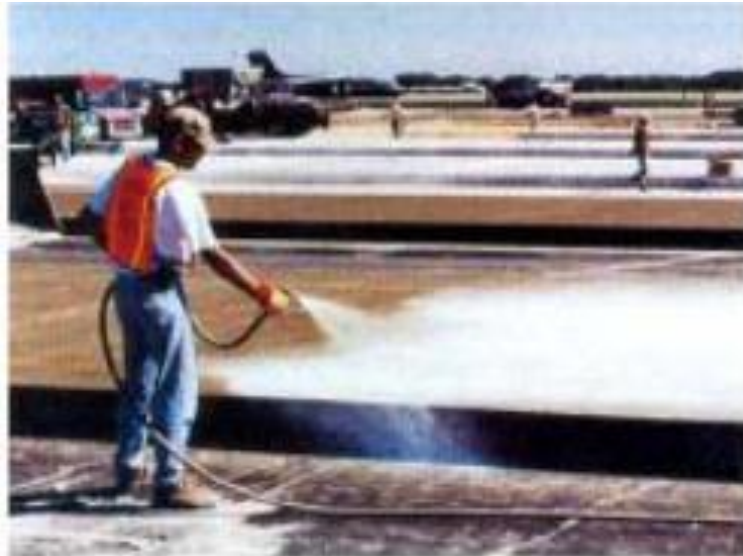
Figura 13: Processo de Cura do Concreto. Fonte: EFFTING
