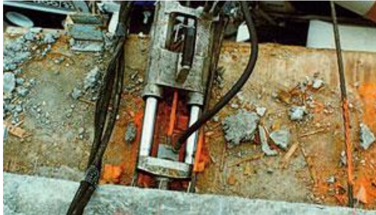
Figura 03: Protensão do Radier Fonte: LIMA
