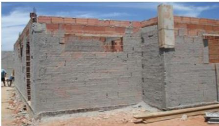
Figura 14: Parede Chapiscada. Fonte: CORRÊA
