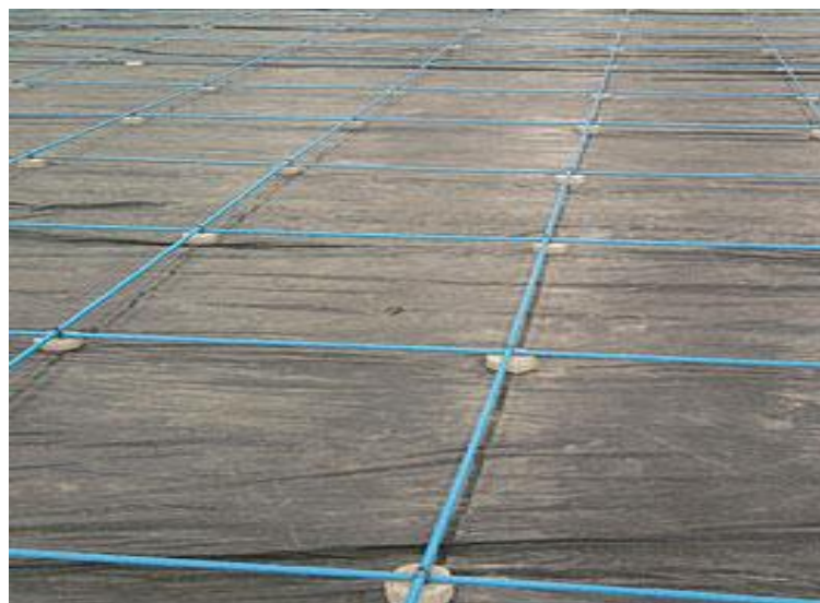
Figura 01: Radier com Cordoalhas Fonte: LIMA
