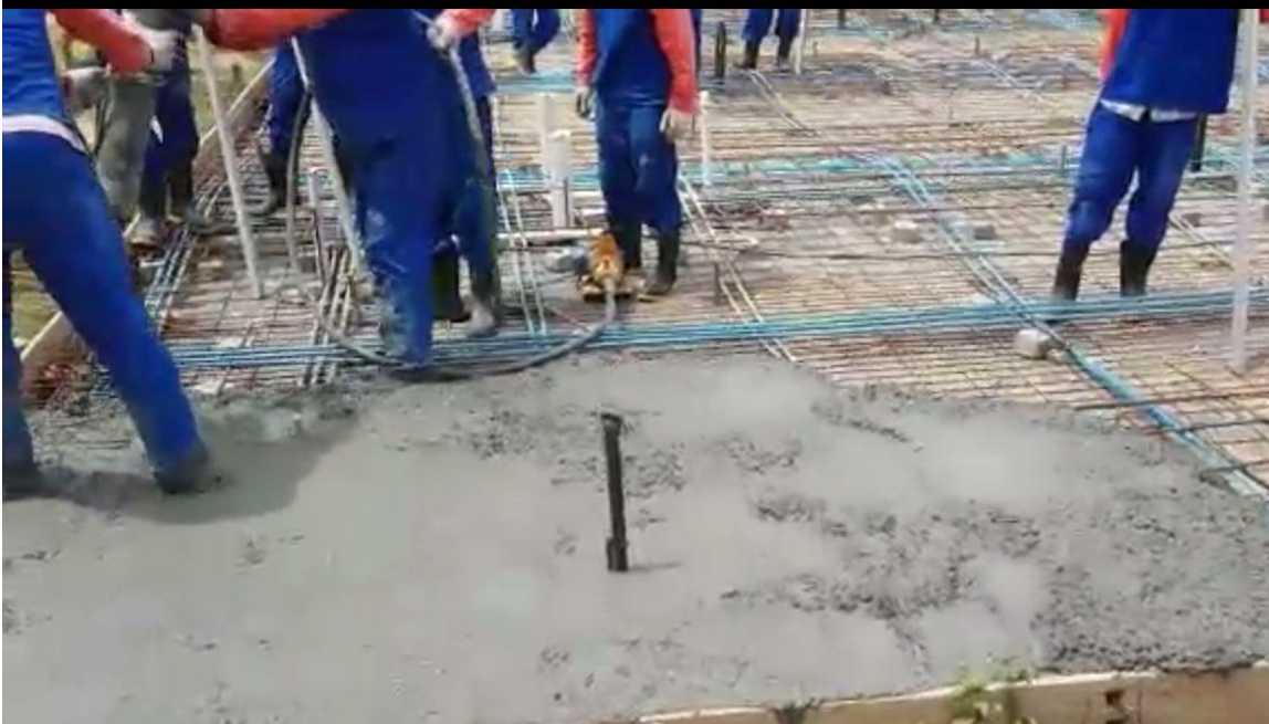
Figura 22: Concretagem do Radier Fonte: Tirada pelo Autor
