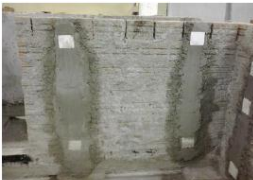
Figura 15: Parede com Talisca e Guias. Fonte: CORRÊA
