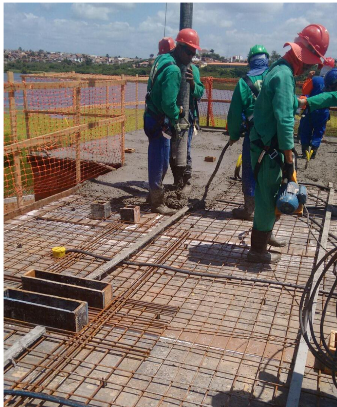
Figura 21: Concretagem e Adensamento da Laje Fonte: Tirada pelo Autor
