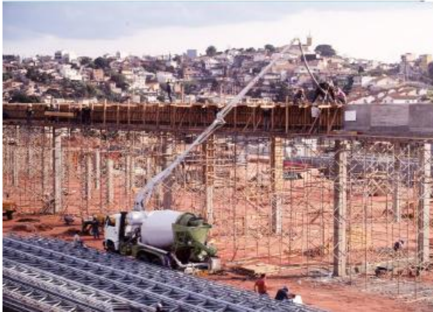
Figura 11: Concretagem Fonte: EFFTING
