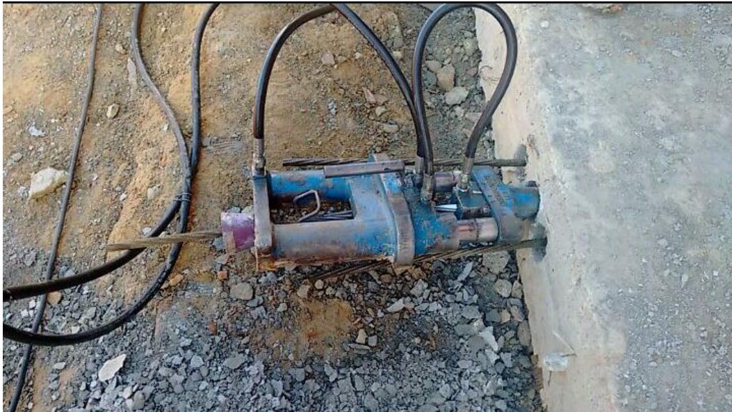
Figura 18: Protensão do Radier. Fonte: Tirada pelo Autor
