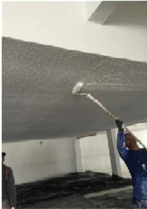
Figura 14: Aplicação da textura no teto
