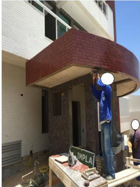
Figura 8: Execução de Revestimento Fonte: Arquivo Pessoal
