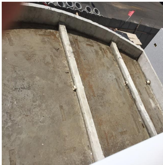
Figura 6: Regularização da laje
