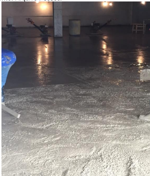
Figura 13: Polimento no concreto Fonte: Arquivo Pessoal
