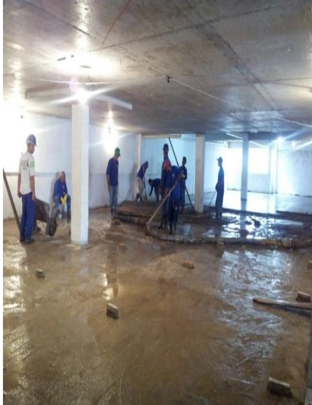
Figura 12: Execução da concretagem da garagem Fonte: Arquivo Pessoal
