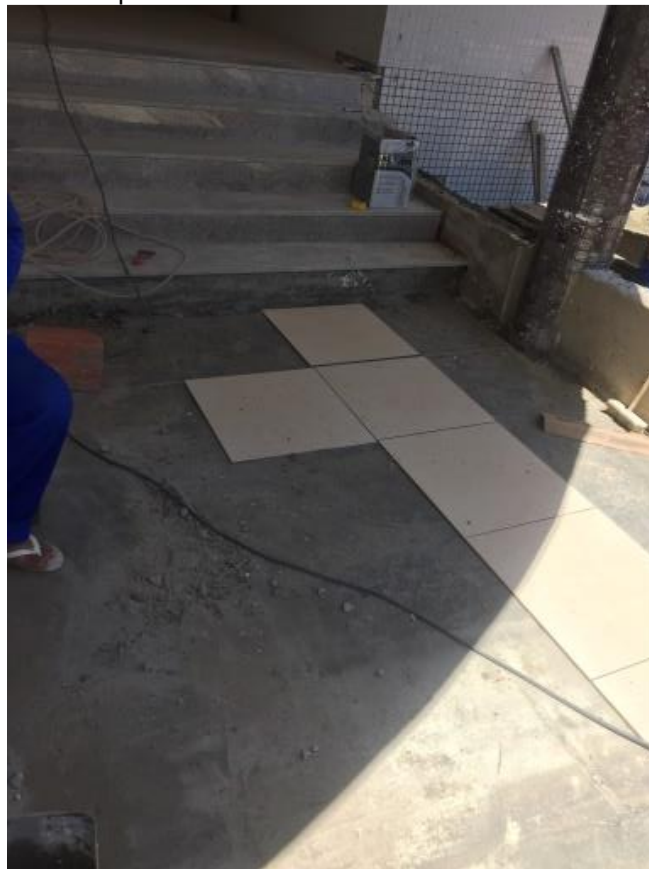
Figura 9: Assentamento de piso Fonte: Arquivo Pessoal
