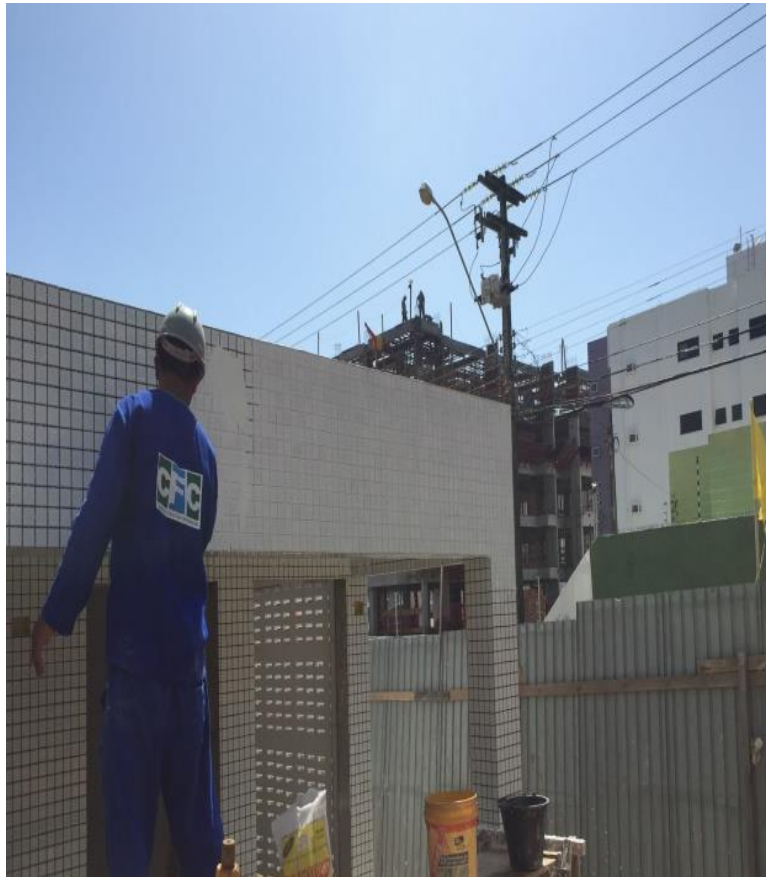
Figura 10: Execução do rejuntamento Fonte: Arquivo pessoal
