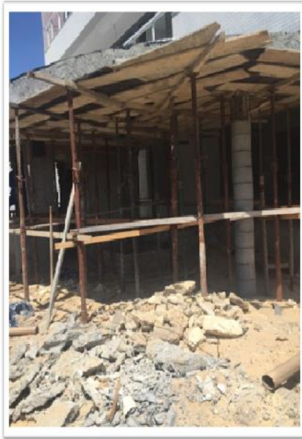
Figura 2: Execução laje da Guarita Fonte: Arquivo Pessoal
