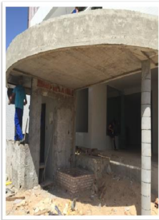
Figura 3: Laje sem escoramentos Fonte: Arquivo Pessoal
