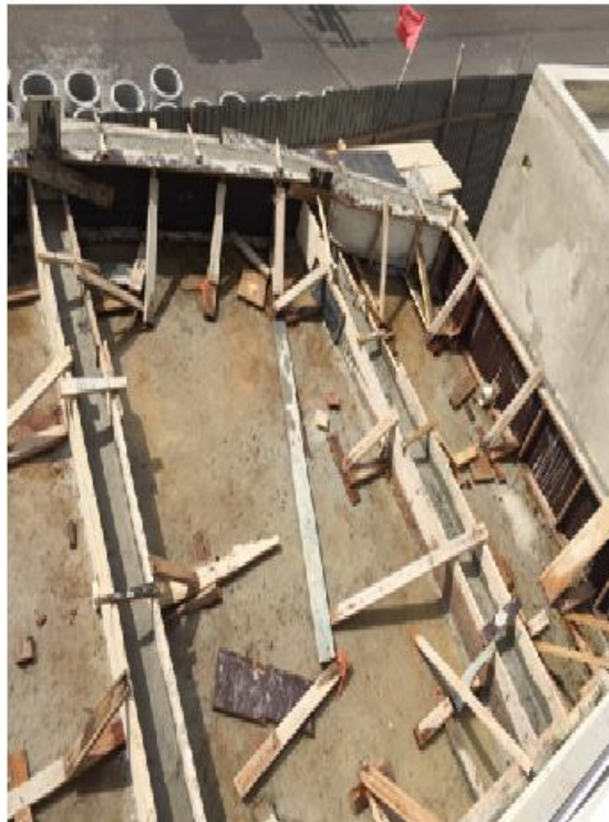
Figura 5: Concretagem das vigas invertidas Fonte: Arquivo Pessoal
