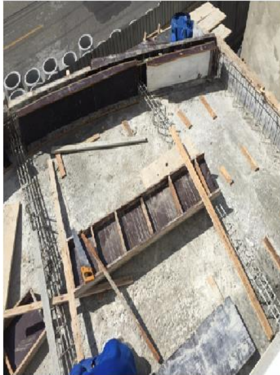
Figura 4: Execução das vigas invertidas Fonte: Arquivo Pessoal
