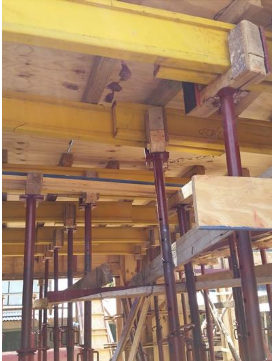
Figura 6: Escoramento metálico e em madeira para concreto.
