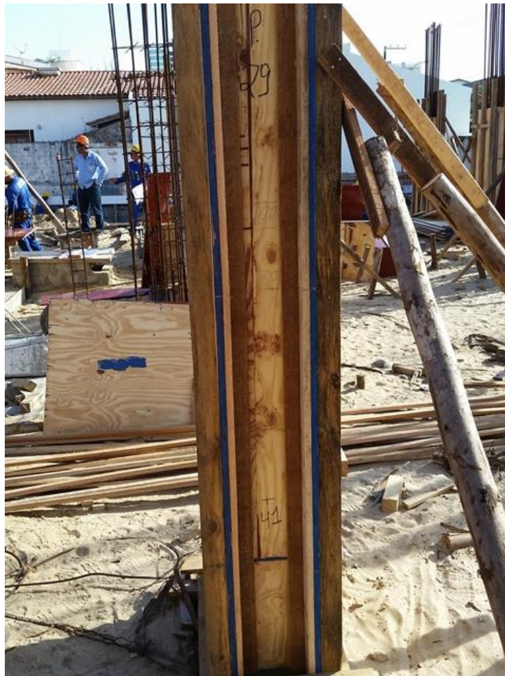
Figura 2 Fôrma de pilar executada
