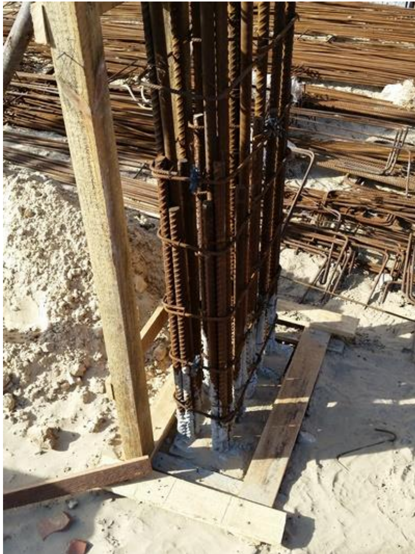
Figura 4: Armadura para pilar pronta e colocada no local.
