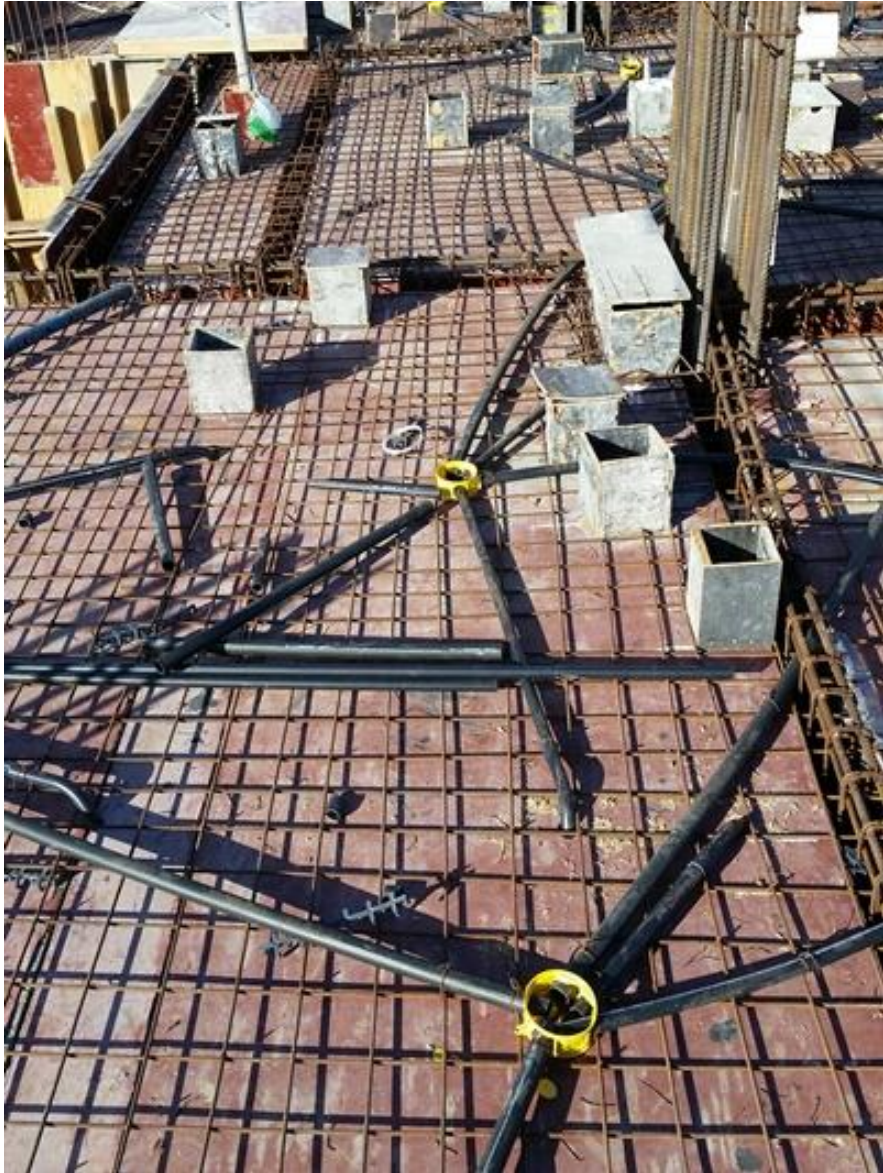
Figura 8: Verificação instalações em laje
