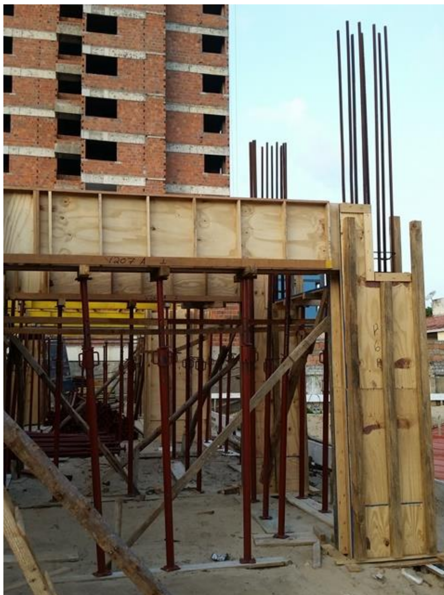
Figura 3: Fôrma de pilar e viga executada
