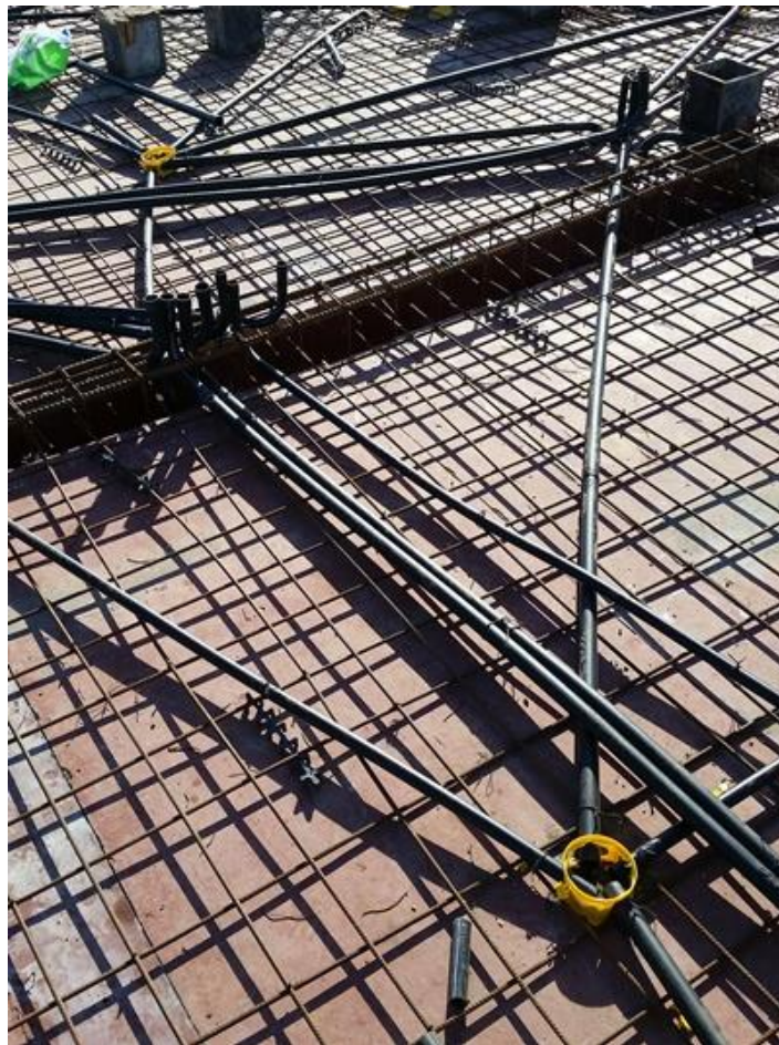
Figura 7: Verificação instalações em laje
