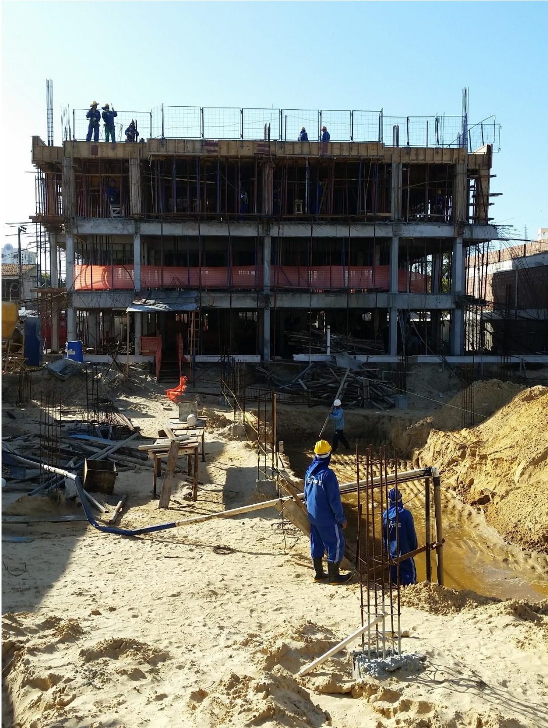
Figura 9: Estrutura de concreto
