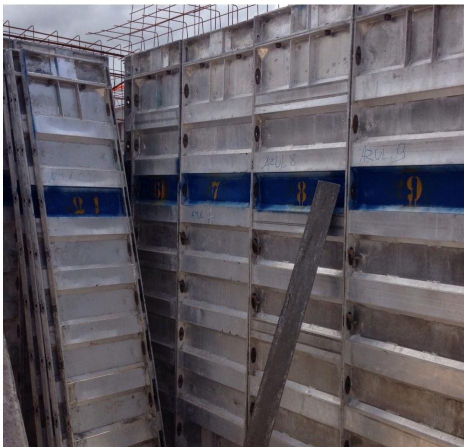
Figura 13 – Fôrmas Metálicas numeradas Fonte: Próprio Autor (2015)
