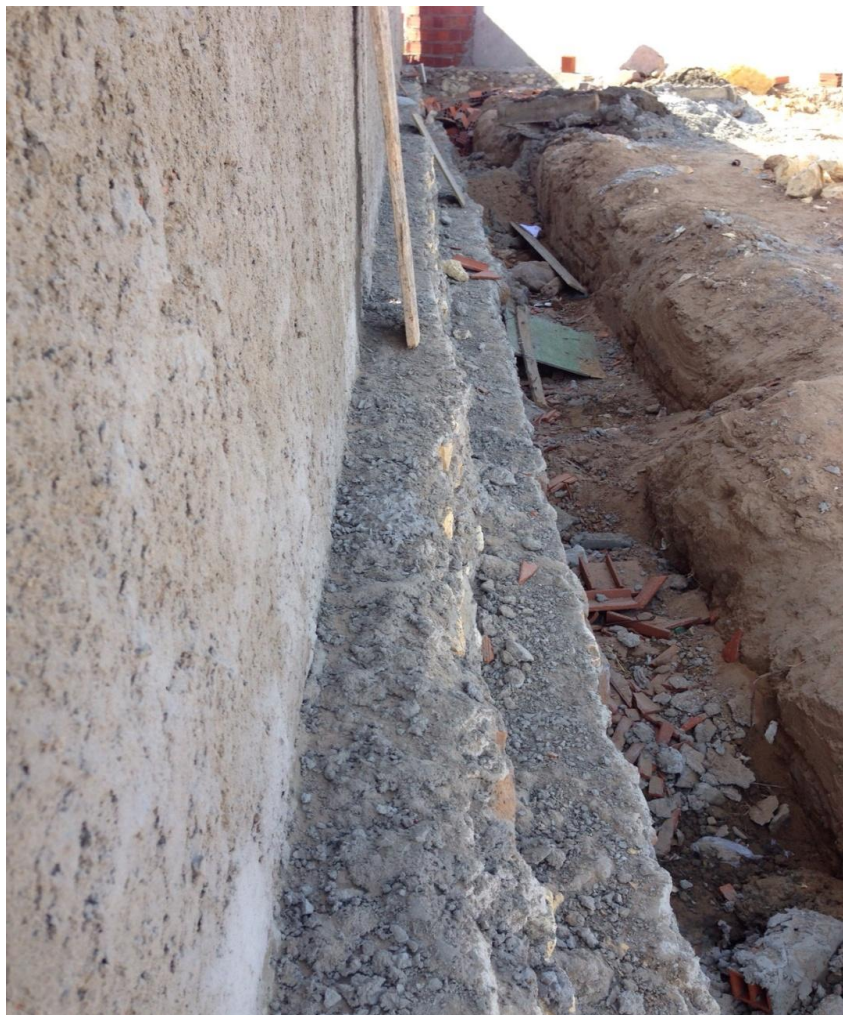
Figura 02 – Camadas do Muro de Arrimo Fonte: Próprio Autor (2015)
