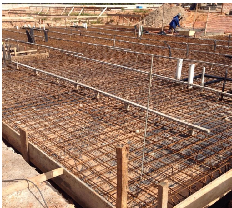
Figura 10 – Radier pronto pra concretagem Fonte: Próprio Autor (2015)
