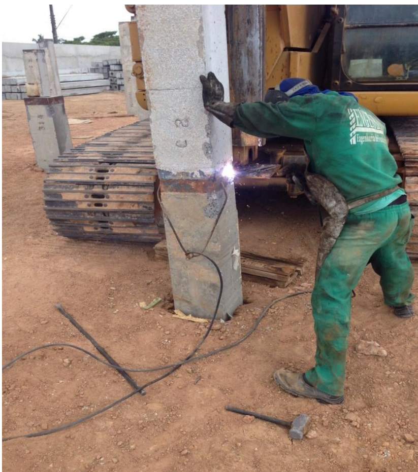
Figura 07 – Soldagem da estaca pré-moldada de concreto Fonte: Próprio Autor (2015)
