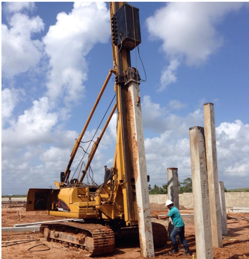
Figura 06 – Colocação da estaca pré-moldada no local determinado Fonte: Próprio Autor (2015)
