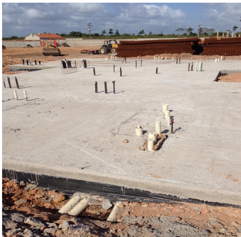
Figura 11 –Radier concretado Fonte: Próprio Autor (2015)
