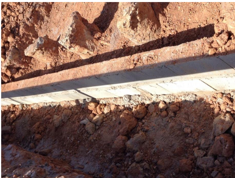
Figura 09 – Embasamento do radier e estacas já arrasadas Fonte: Próprio Autor (2015)
