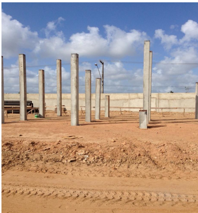
Figura 08 – Estacas pré-moldadas de concreto Fonte: Próprio Autor (2015)
