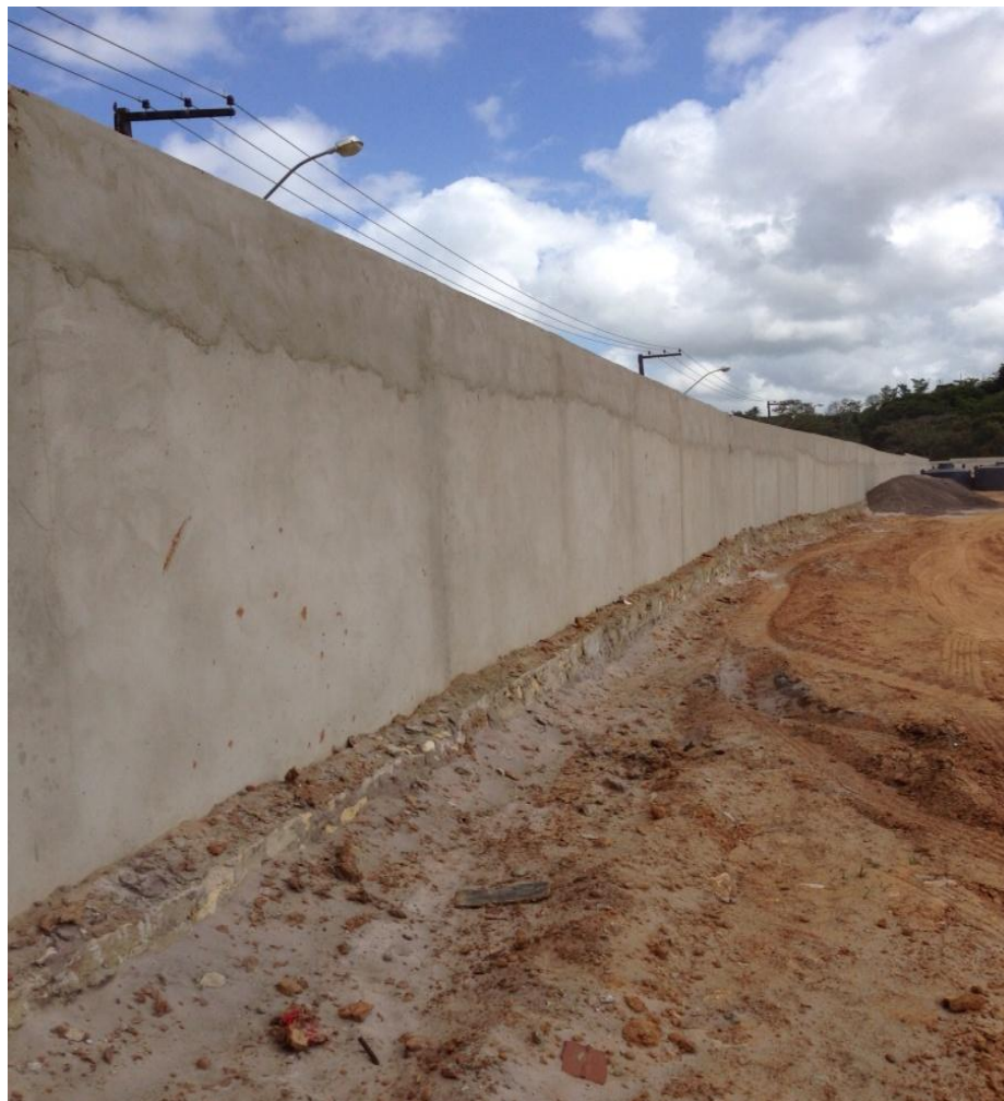
Figura 03 – Muro de Arrimo Fonte: Próprio Autor (2015)
