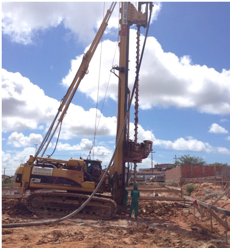
Figura 04 – Concretagem da estaca hélice-contínua Fonte: Próprio Autor (2015)
