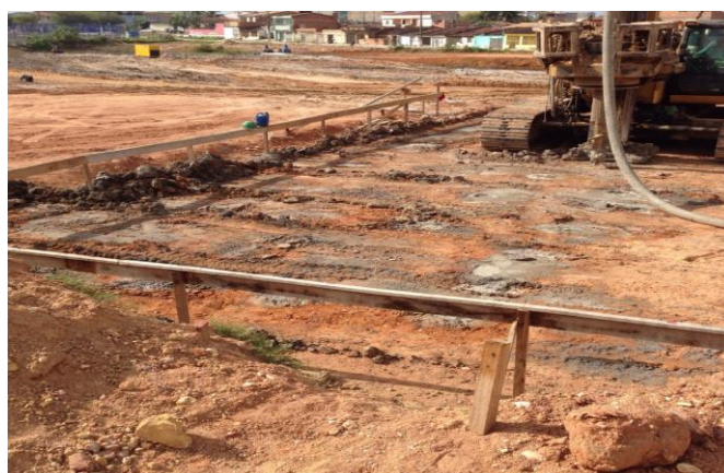
Figura 05 – Estacas tipo hélice-contínua concretadas Fonte: Próprio Autor (2015)
