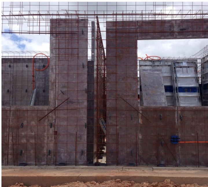
Figura 14 – Colocação das Fôrmas
