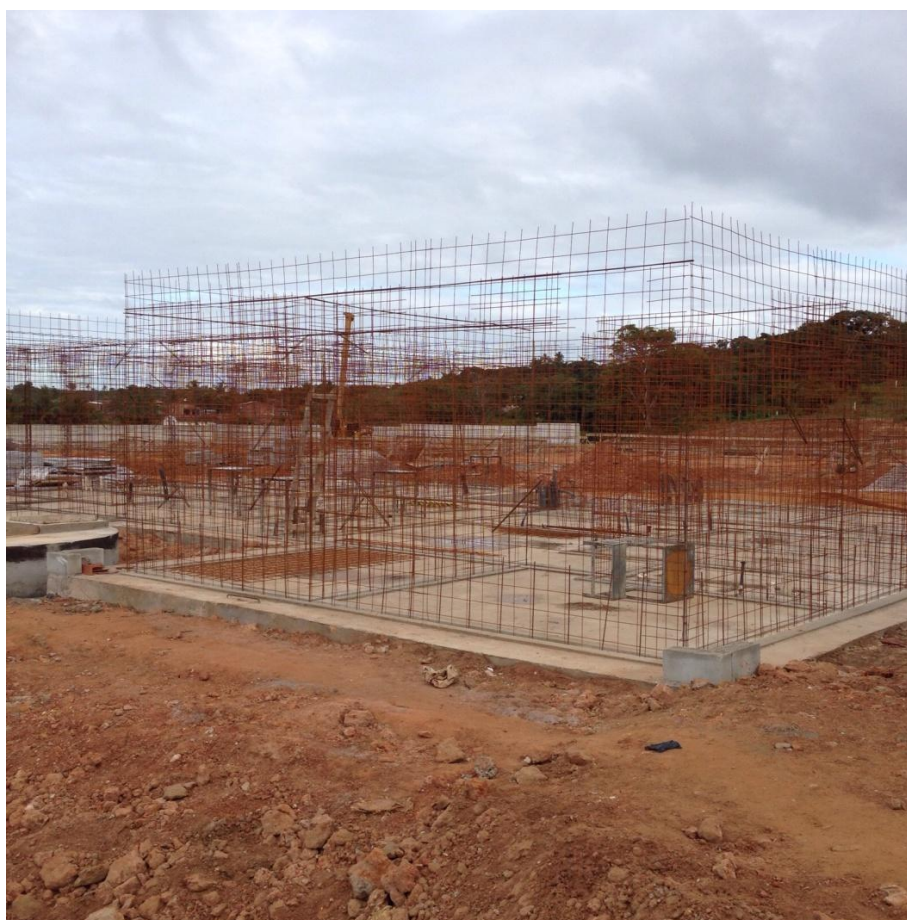
Figura 12 – Ferragem da parede de concreto Fonte: Próprio Autor (2015)
