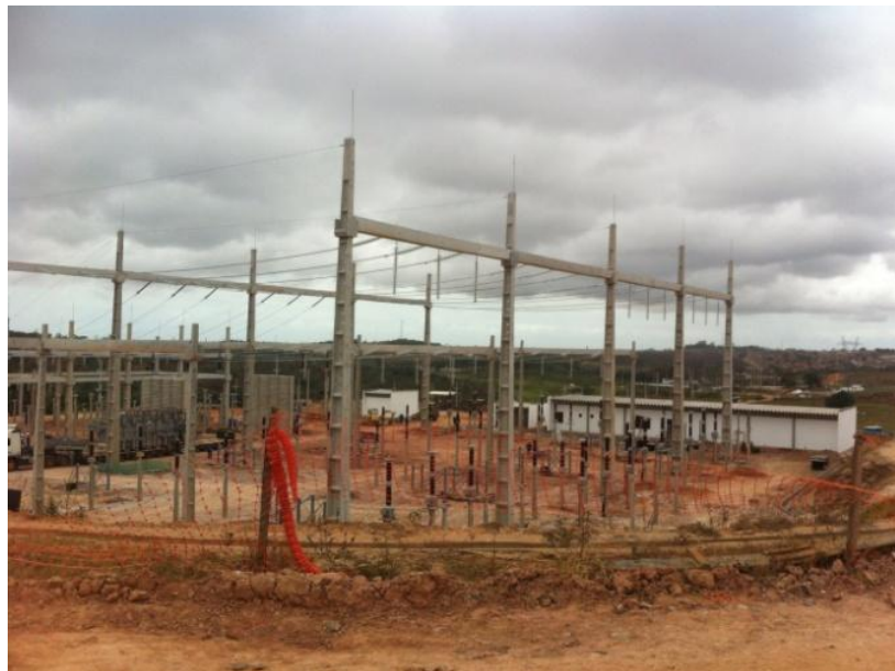
Figura 8: Área de Construção da Subestação
