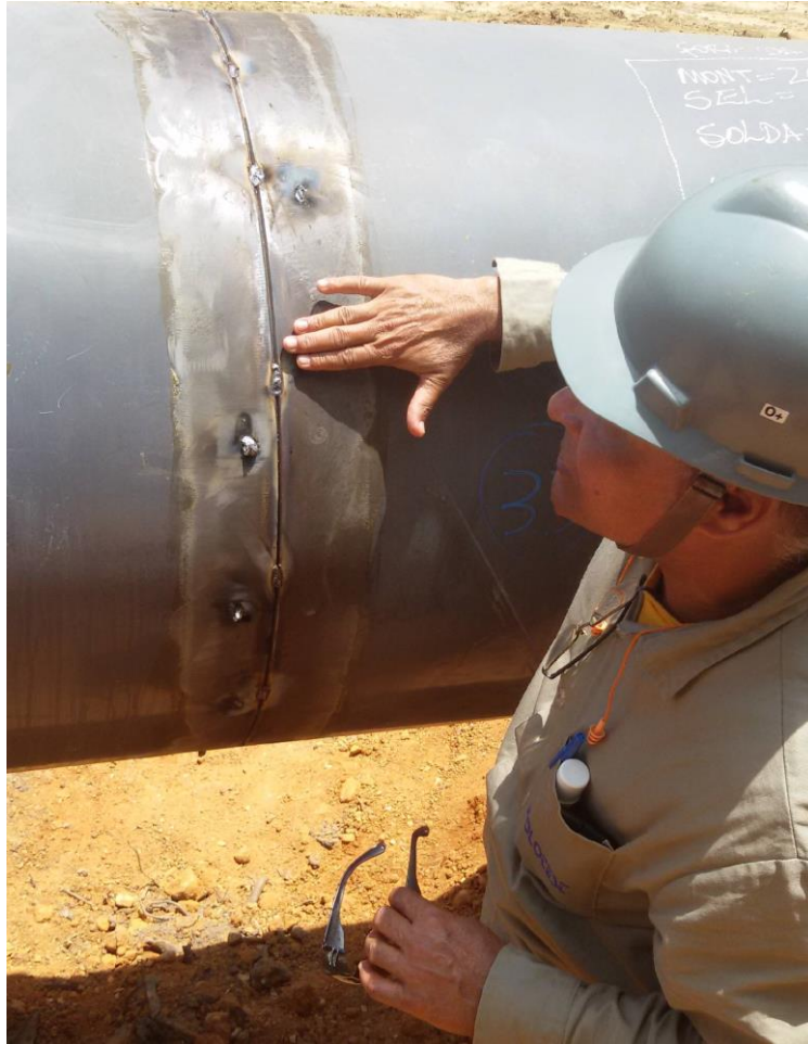
Figura 7 – Tubos Soldados Fonte: Arquivo pessoal, 2015
