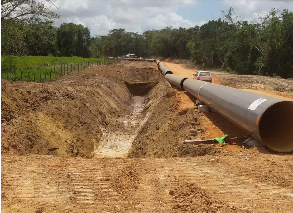
Figura 5 – Vala Escavada Fonte: Arquivo pessoal, 2015
