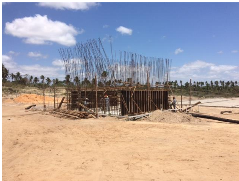
FIGURA 3.21 – execução do reservatório. Fonte: Autoria própria
