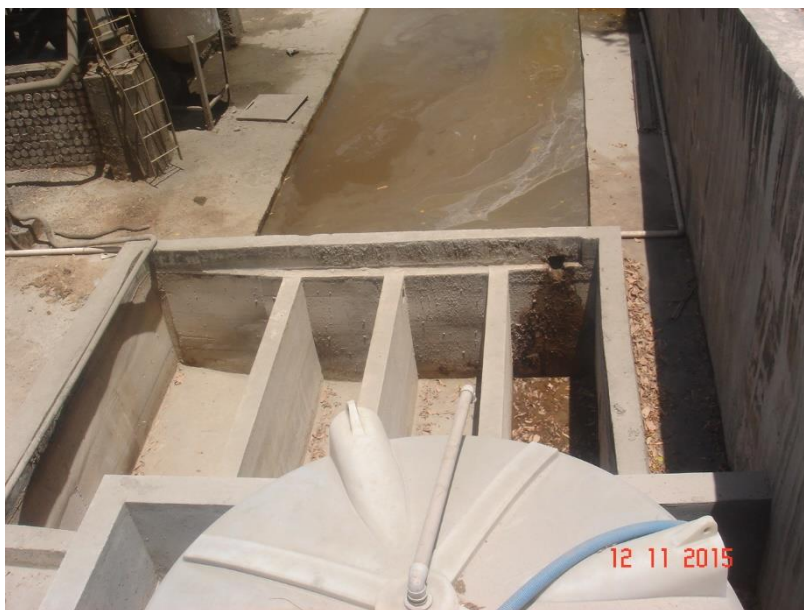
FIGURA 3.17 – Tanque de decantação em fase de acabamento. Fonte: Autoria própria
