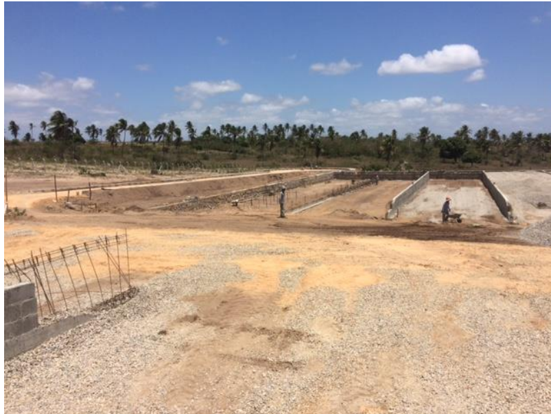
FIGURA 3.23 – nível em que se encontra a obra. Fonte: Autoria própria
