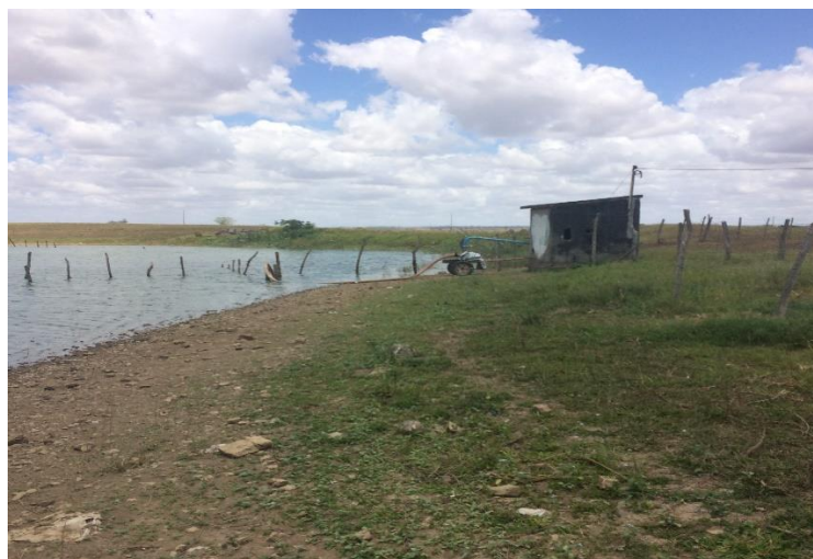
FIGURA 3.7 – Captação da água contaminada Fonte: Autoria própria
