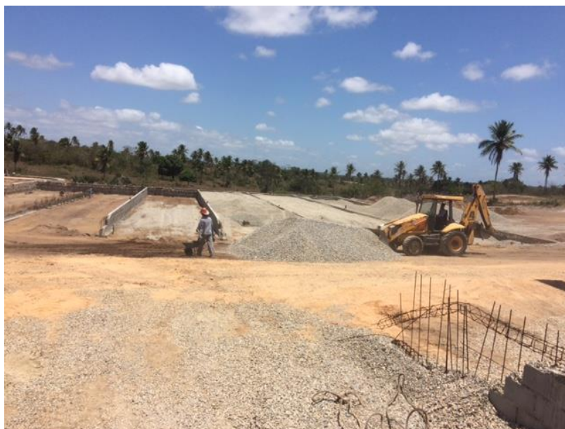
FIGURA 3.22 – Despejar de britas. Fonte: Autoria própria
