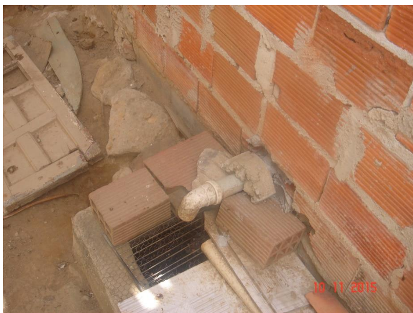
FIGURA 3.3 – Caixa de inspeção Fonte: Aatoria própria
