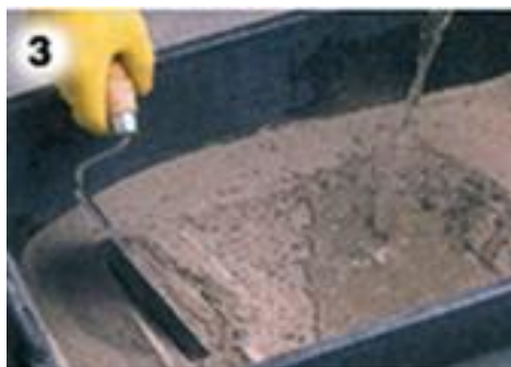
Figura 18: Mistura da argamassa
