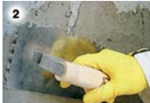
Figura 17: Camada de emboço
