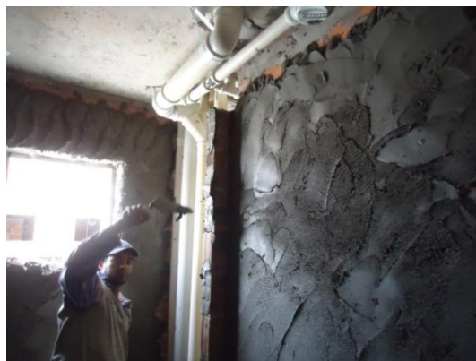
Figura 11: Emboço do banheiro Fonte: Arquivo pessoal
