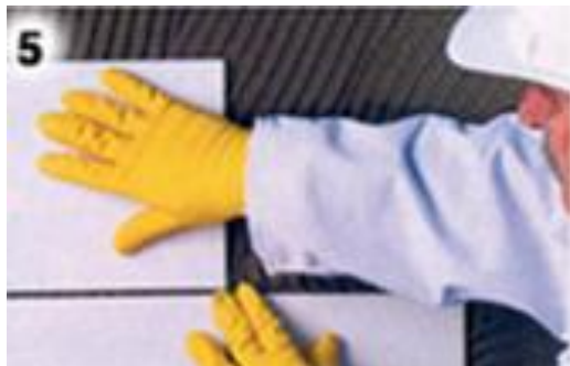
Figura 20: Assentamento da cerâmica.
