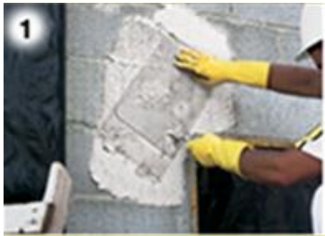
Figura 16: Chapisco de alvenaria externa.
