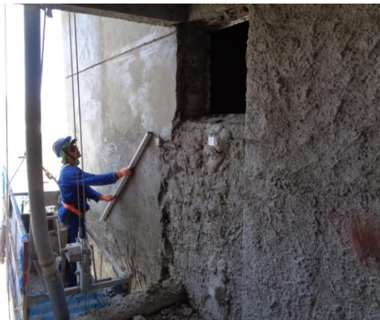
Figura 6: Emboço da Fachada Fonte: Arquivo pessoal
