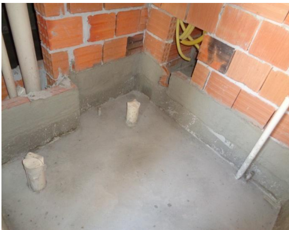
Figura 2: Impermeabilização do WC Fonte: Arquivo pessoal
