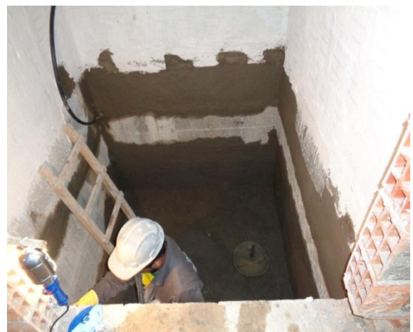
Figura 3: Impermeabilização do poço do elevador Fonte: Arquivo pessoal
