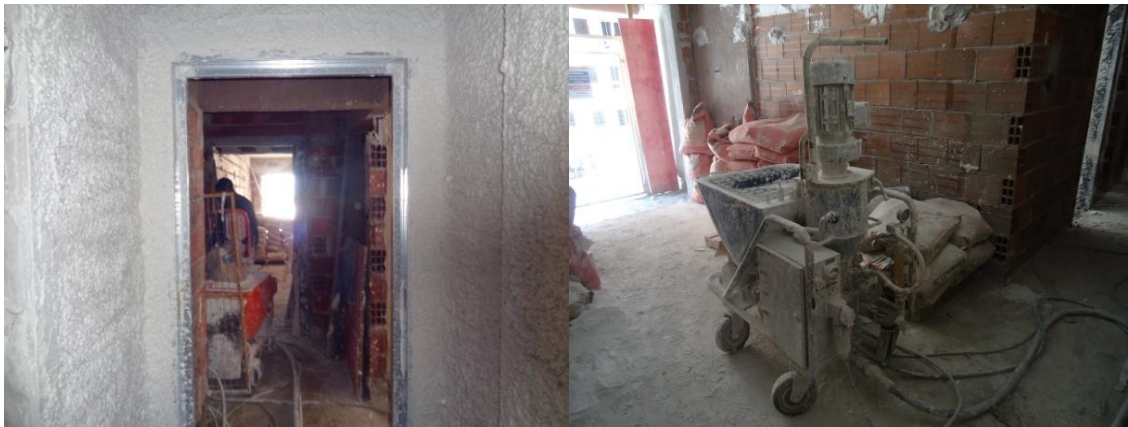
Figura 10: Gesso projetado Fonte: Autor, 2015
