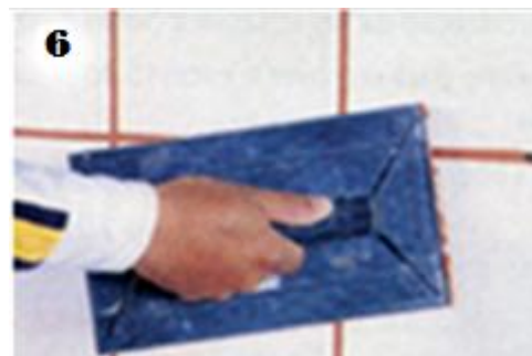
Figura 21: Assentamento da Cerâmica.
