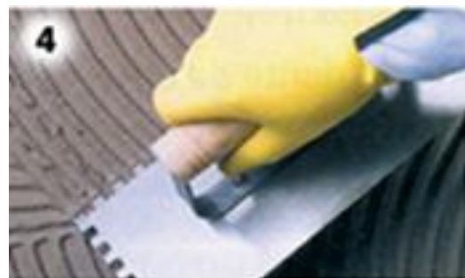
Figura 19: Aplicação da argamassa colante
