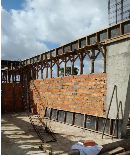
Figura 20: Preparação da forma da viga.
