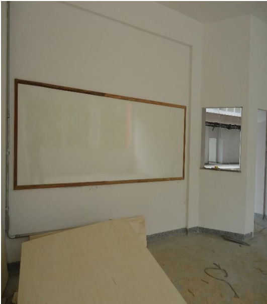
Figura 8: Quadro já fixado.
