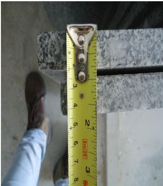
Figura 4: Conferência da espessura do granito.
