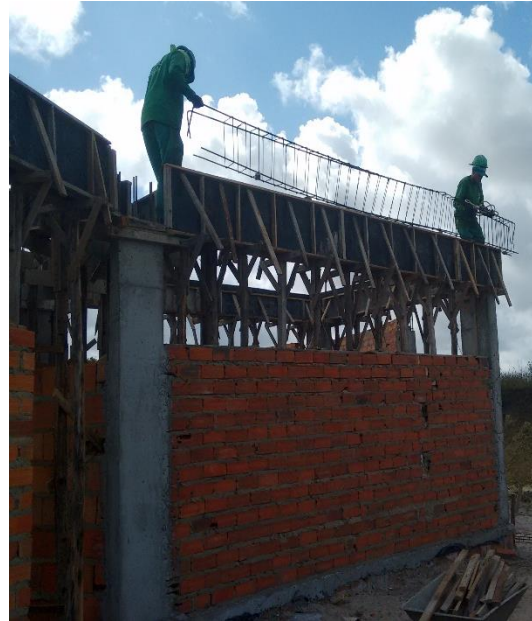
Figura 21: Inserindo a armadura na fôrma.
