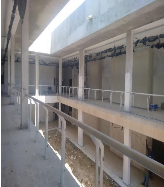
Figura 10: Vista do guarda-corpo no 1º andar.
