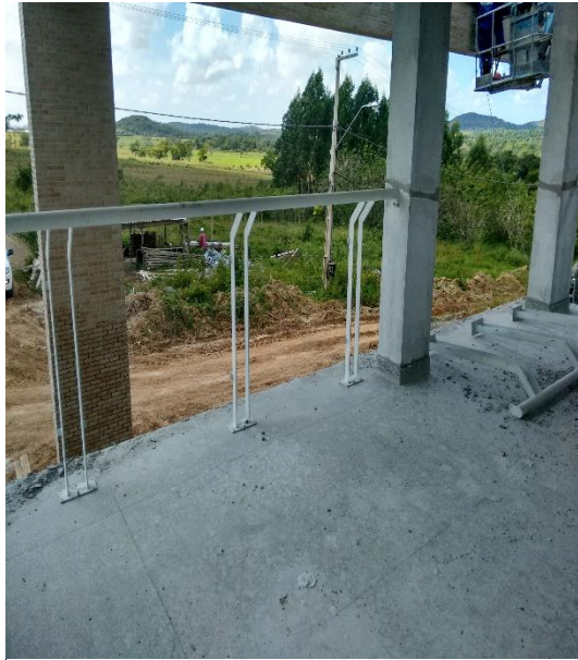
Figura 9: Preparação do guarda-corpo.
