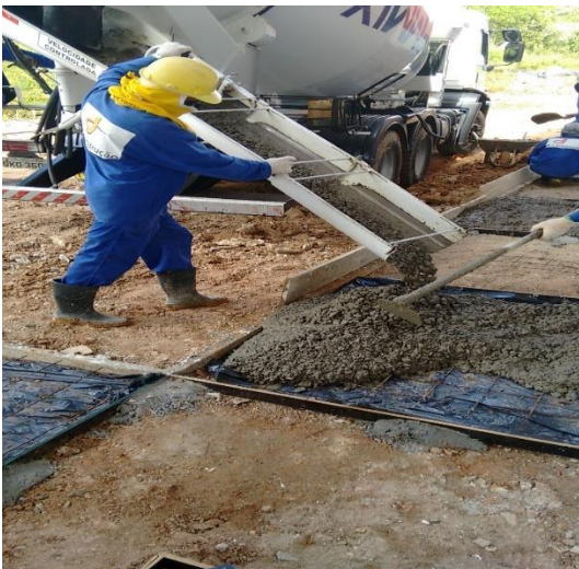
Figura 14: Concretagem da calçada.
