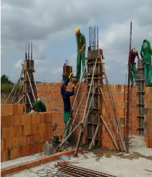
Figura 12: Concretagem do pilar.
