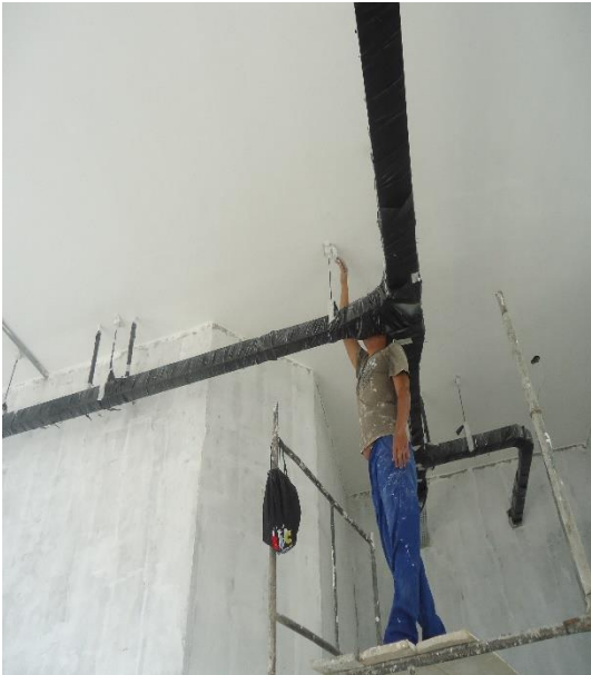
Figura 18: Aplicação da massa corrida no teto.
