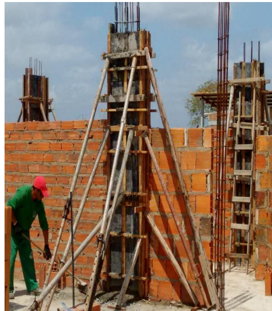
Figura 13: Preparação da fôrma do pilar.
