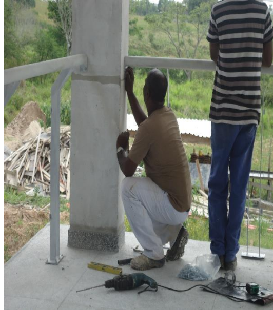
Figura 11: Fixação do guarda-corpo no pilar.
