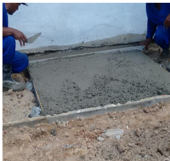
Figura 15: Sarrafeando após a concretagem.
