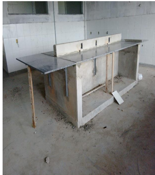
Figura 5: Granito já colocado na bancada.
