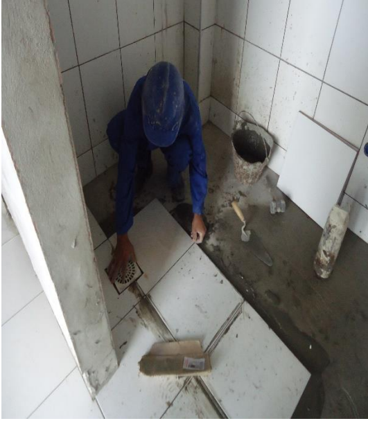
Figura 16: Aplicação de cerâmica no banheiro
