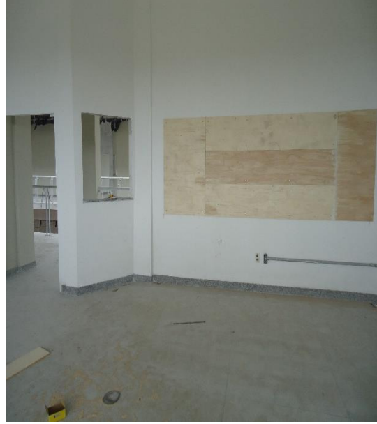
Figura 7: Preparação para fixação do quadro.
