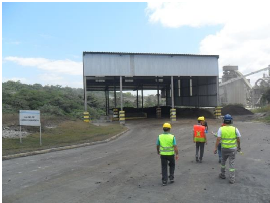
Figura 15 Galpão de deposição do material
