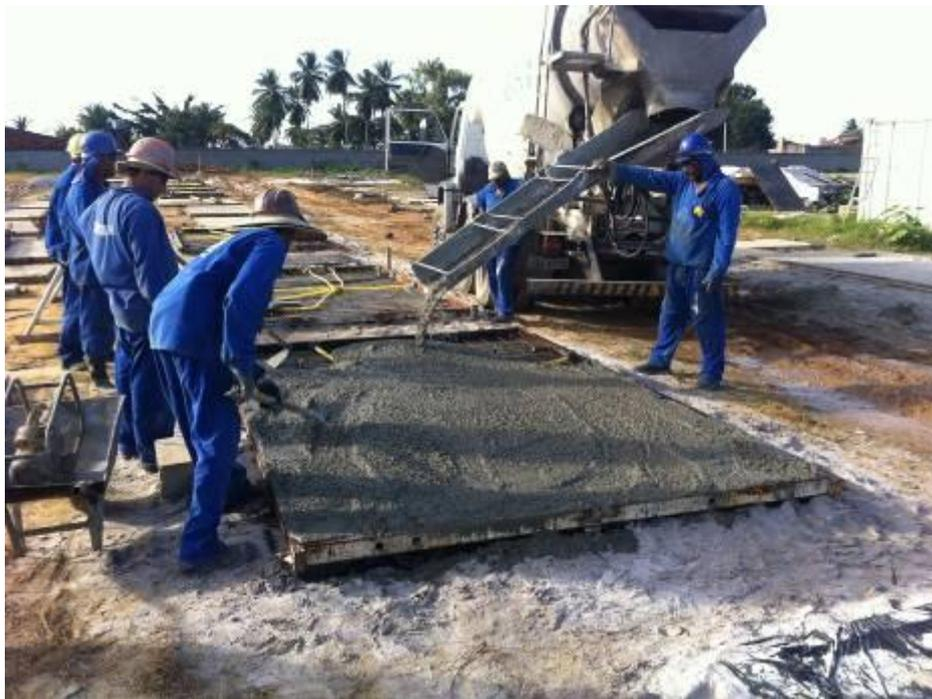
**Figura 6 - Concretagem**
