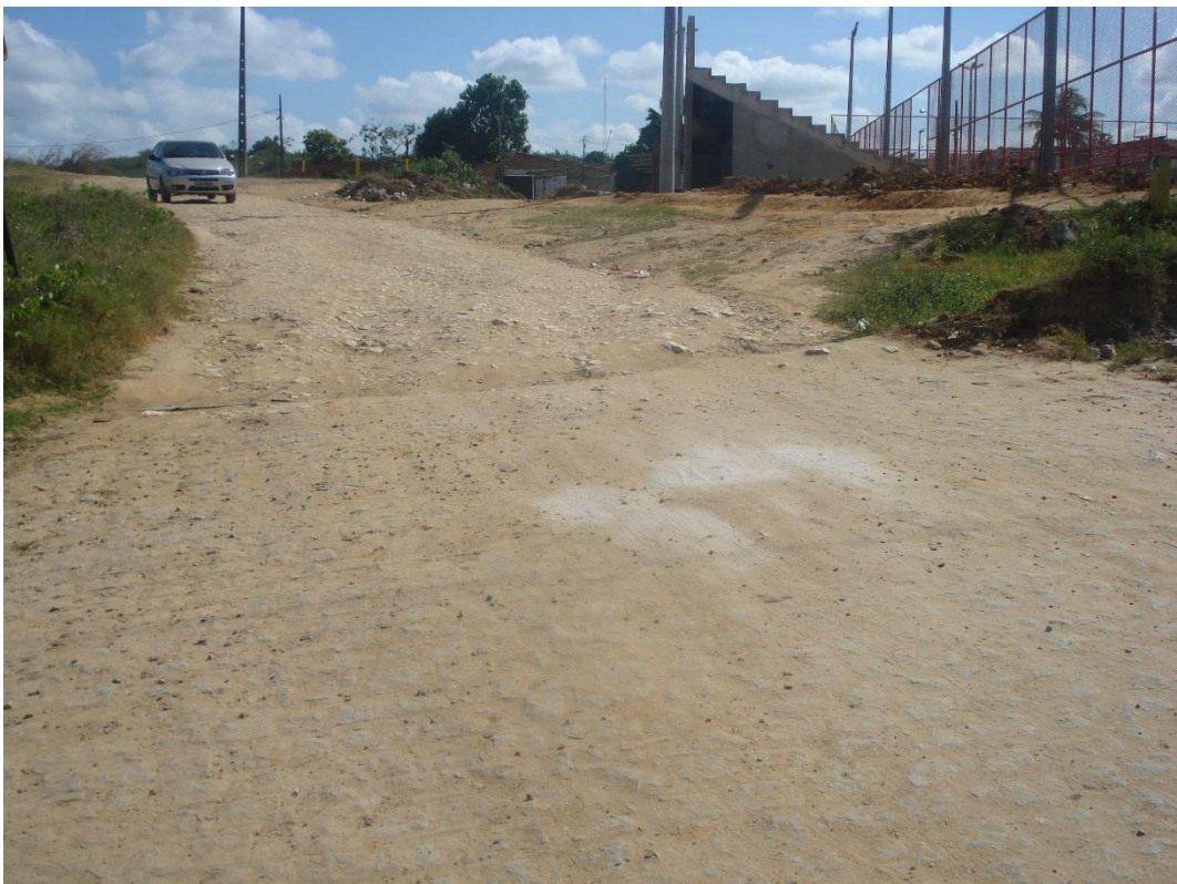
Figura 21. Estrada que será pavimentada no entorno do PEC
