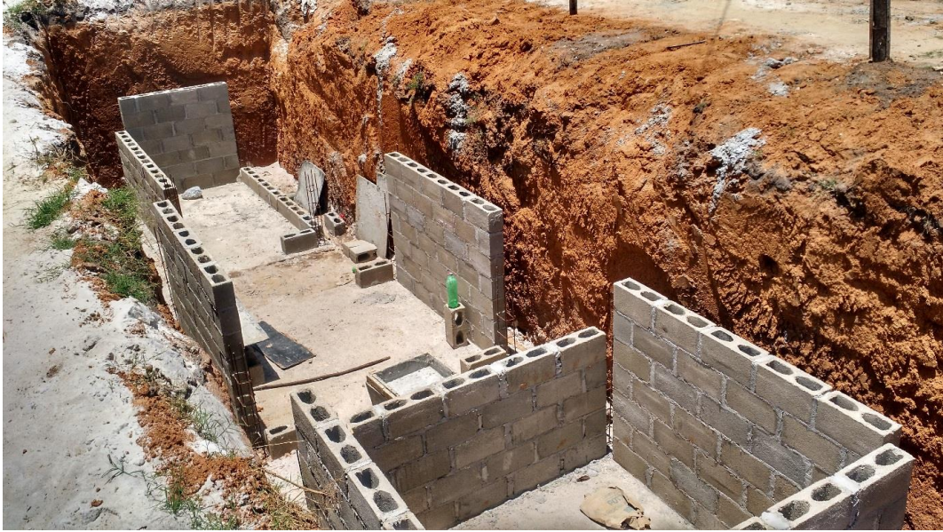
Figura 20. Construção da Fossa séptica
