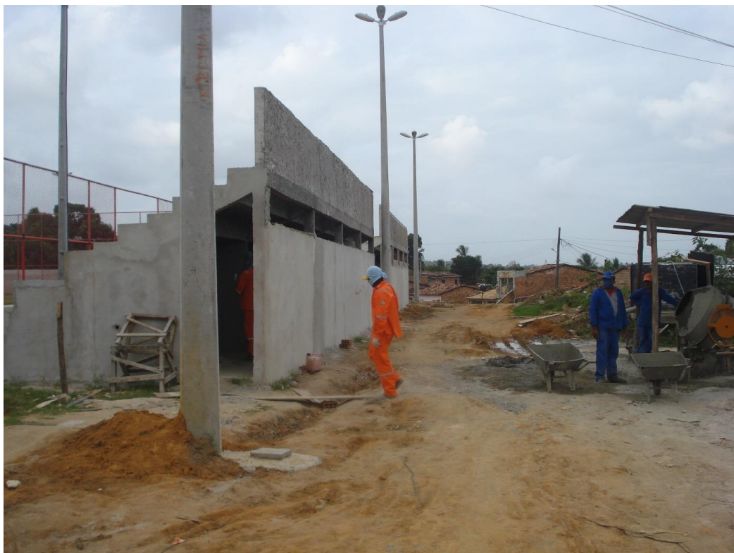
Figura 19. Arquibancada concretada
