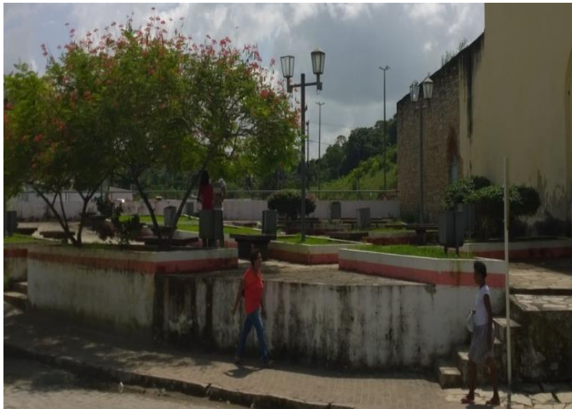
Figura 10. Trecho da praça onde será inserido guarda-corpo.
