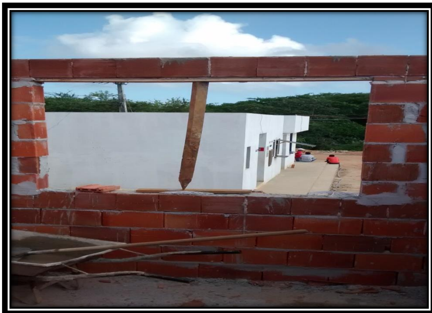
FIGURA 28. Escoramento de contraverga de janela
