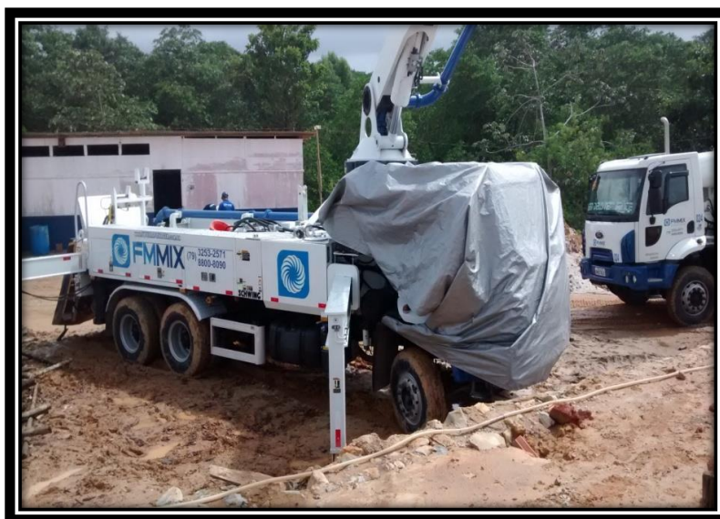
FIGURA 04. Caminhão bomba, distribuidor de concreto ao edifício
