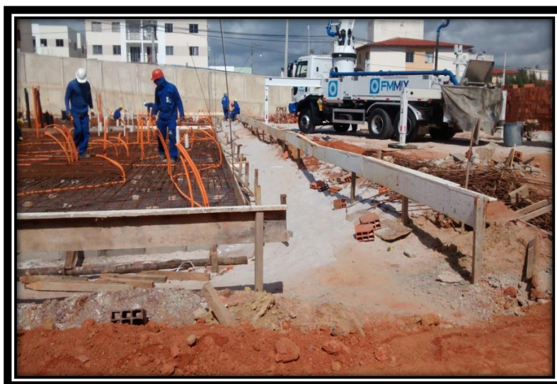
FIGURA 16. Gabarito de Obra
