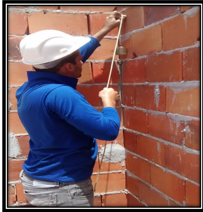
FIGURA 19. Conferência de prumo em alvenaria
