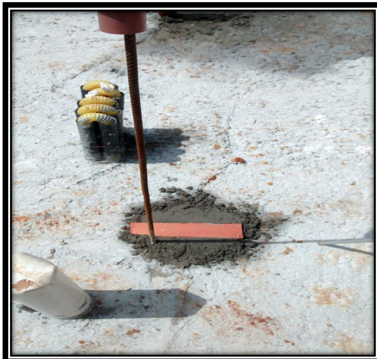
FIGURA 11. Mestras do contrapiso, marcadas em função dos grautes.
