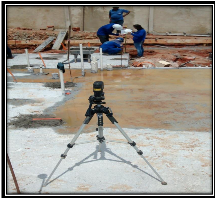
FIGURA 10. Nível utilizado para transferências de cotas.
