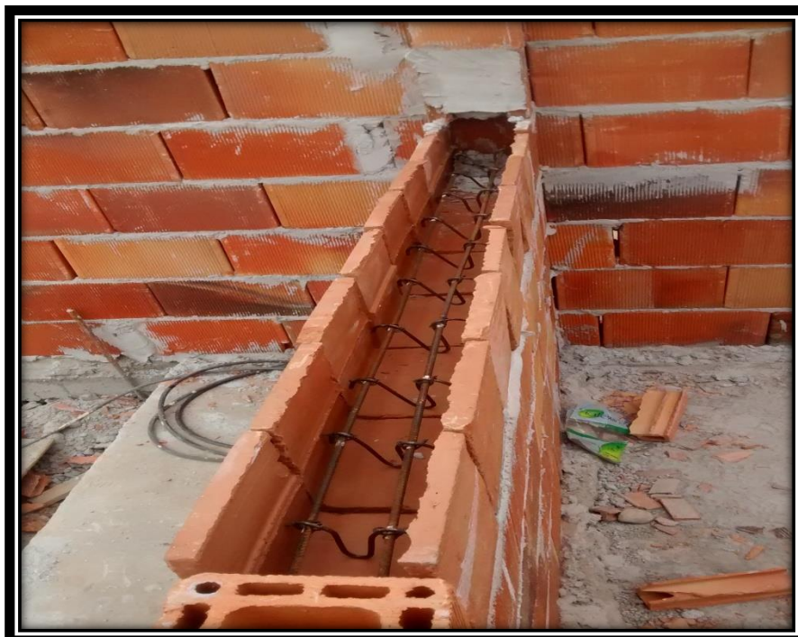
FIGURA 26. Vergalhão para contravega de janela
