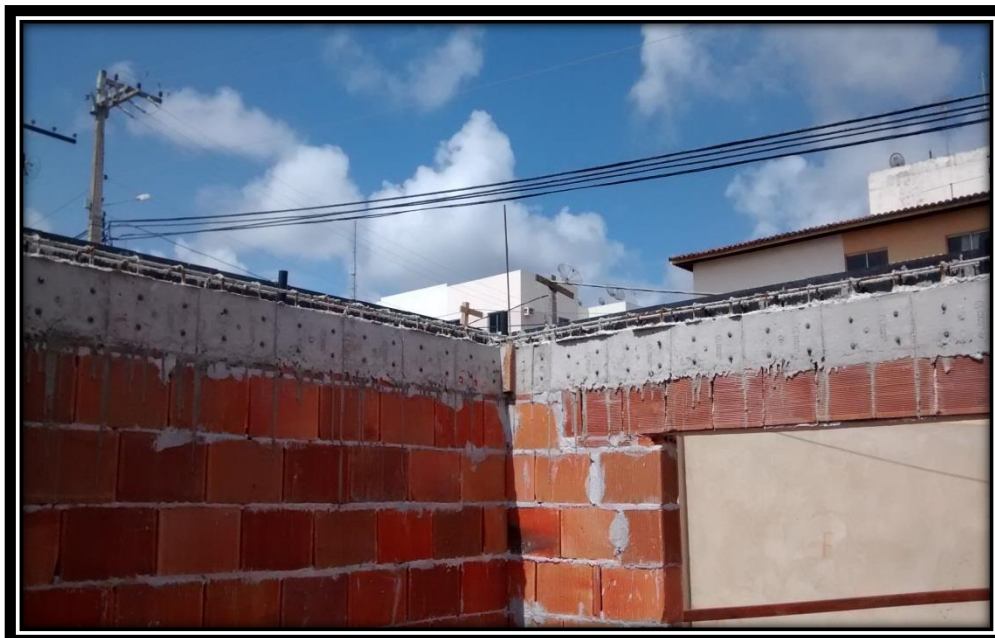
FIGURA 34. Argolamento após desfôrma
