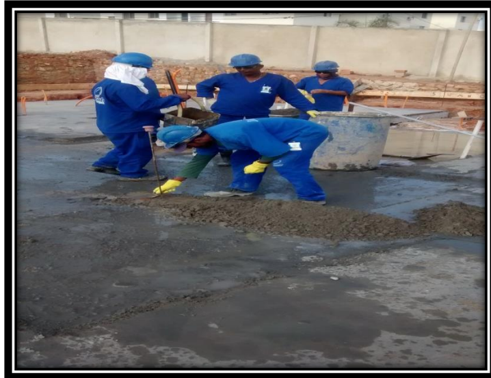
FIGURA 13. O despejo da massa do contrapiso na área requerida
