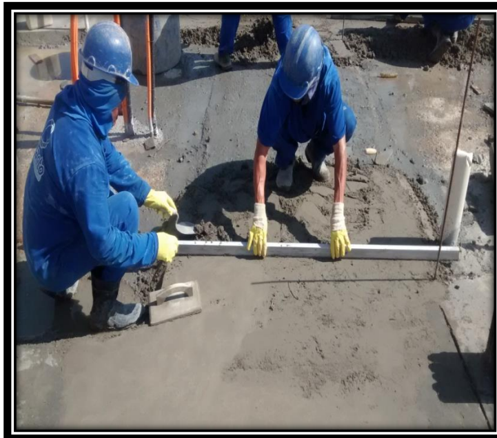
FIGURA 14. Uso de sarrafos para padronização da espessura
