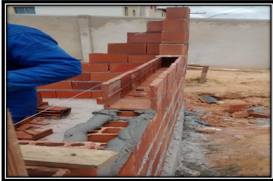
FIGURA 25. Assentamento de calhas para contravega
