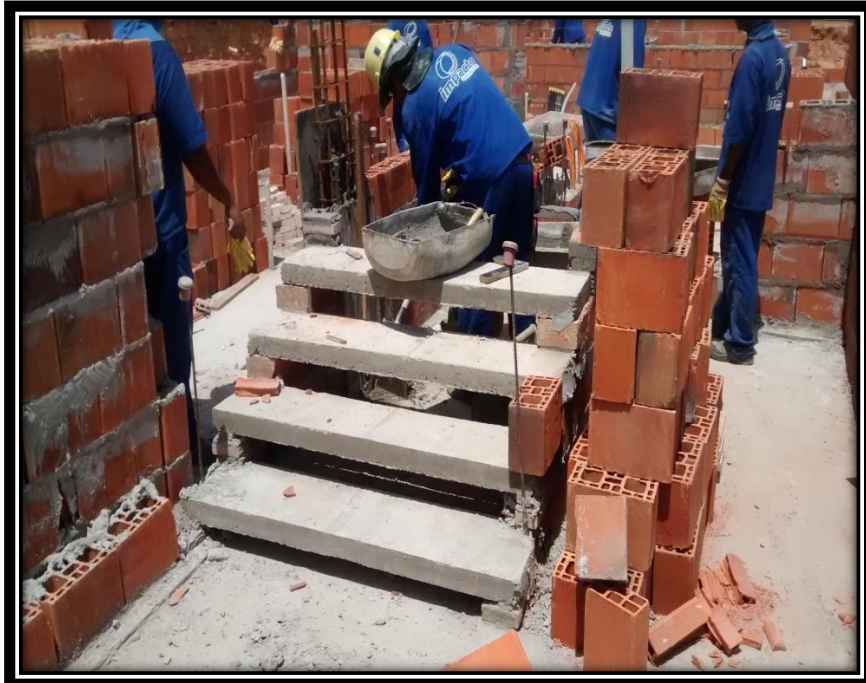
FIGURA 30. Degraus pré-moldados montados sobre alvenaria
