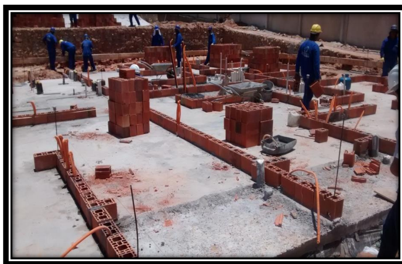
FIGURA 17. Marcação das paredes de alvenaria estrutural
