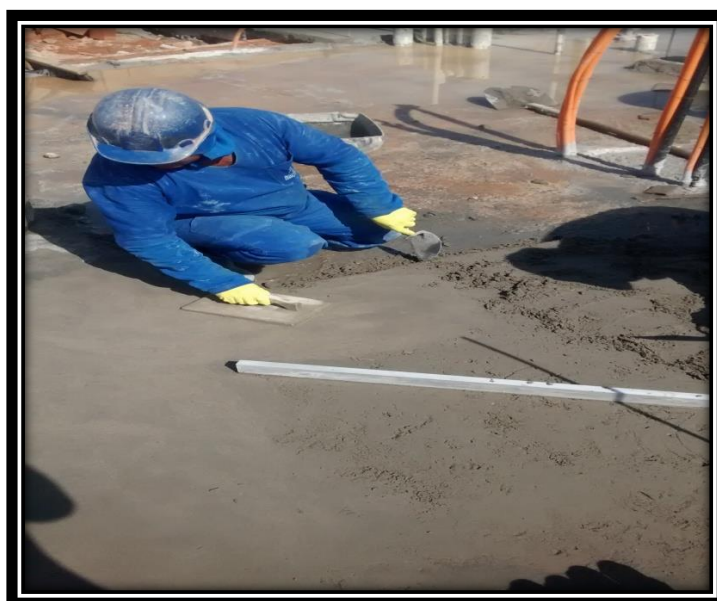
FIGURA 15. Uso de desempoladeira para perfeito alisamento
