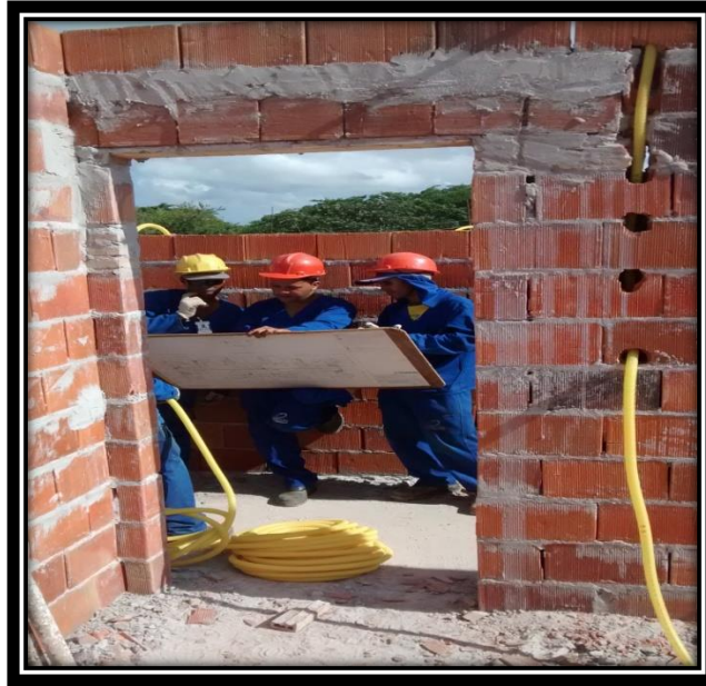
FIGURA 23. Verga de porta finalizada
