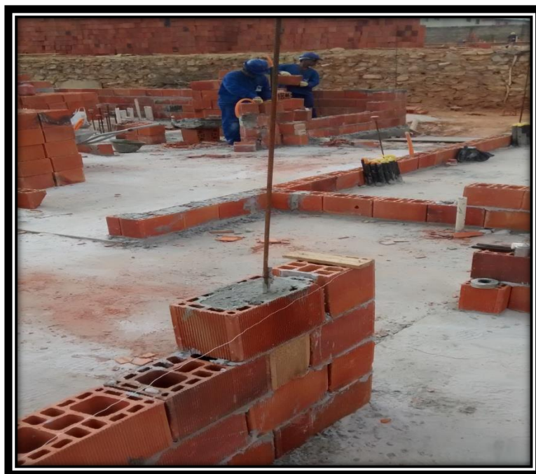
FIGURA 29. Graute em Alvenaria Estrutural
