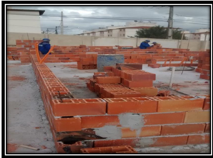
FIGURA 18. Andamento do Levante de Alvenaria Estrutural
