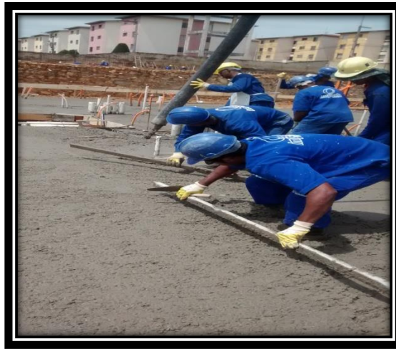
FIGURA 02. Sarrafeamento do Concreto
