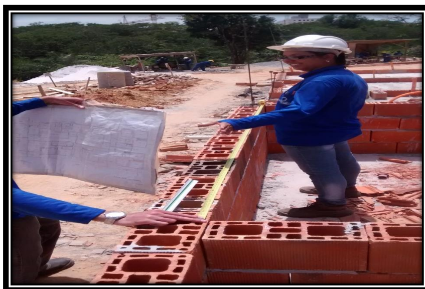
FIGURA 24. Marcação de janelas.
