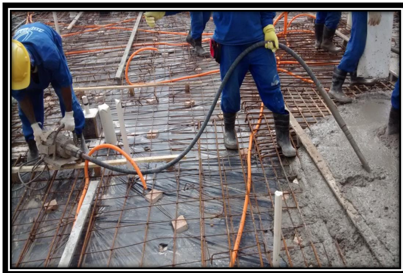
FIGURA 03. Mangote utilizado em concretagens.
