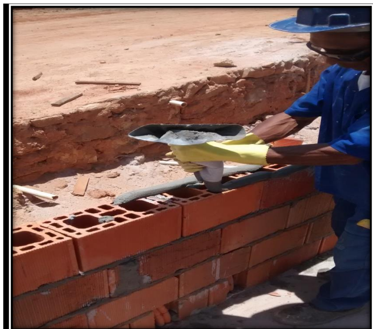
FIGURA 22. Bisnaga usada na aplicação de argamassa em alvenaria
