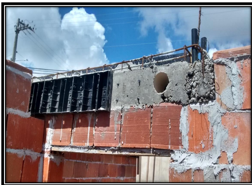
FIGURA 35. Passagem hidrossanitária através do argolamento
