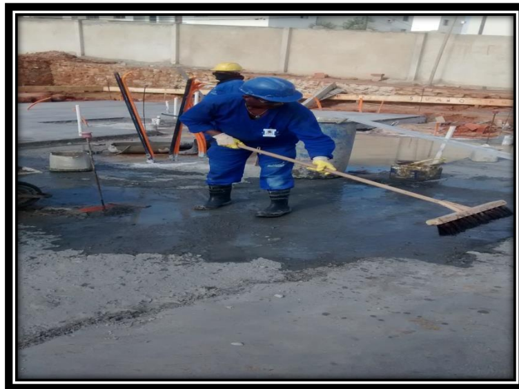
FIGURA 12. A umidificação da superfície. Preparo para o contrapiso
