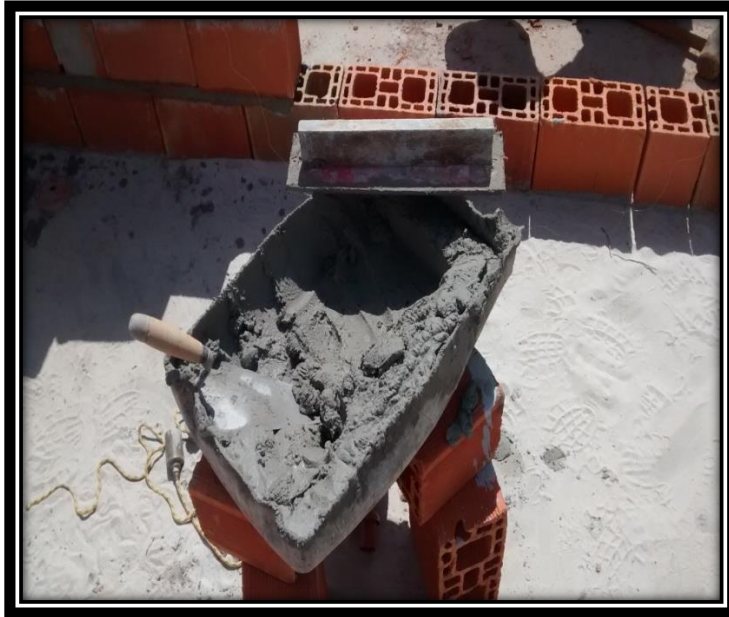
FIGURA 21. Colher e Palheta, Utensílios dos Pedreiros
