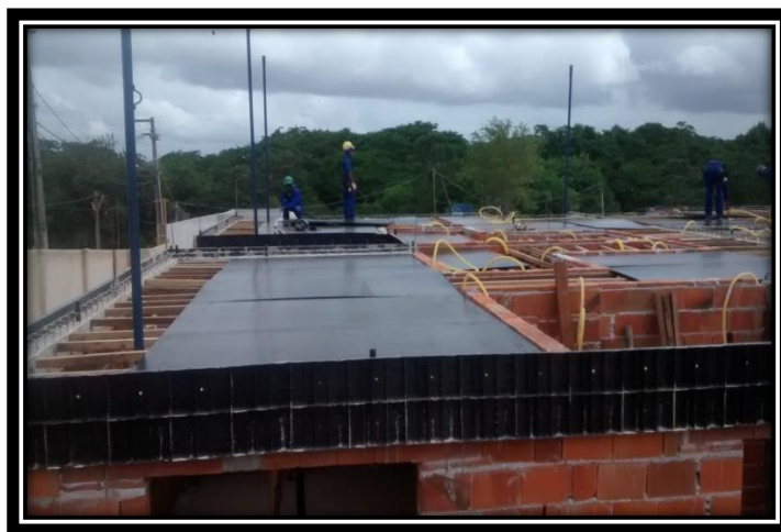
FIGURA 37. Vista superior das fôrmas postas
