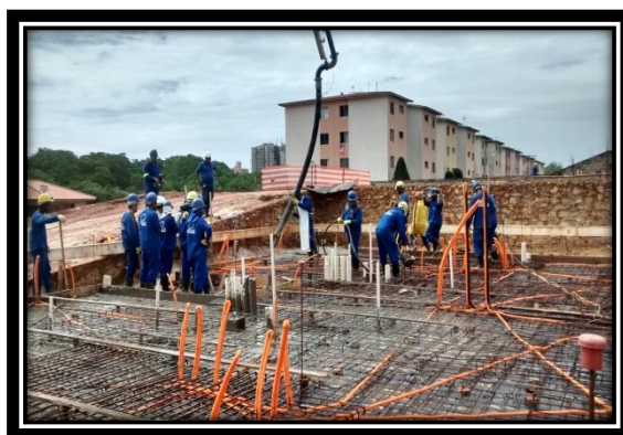
FIGURA 01. Concretagem do térreo da Torre Alísios
