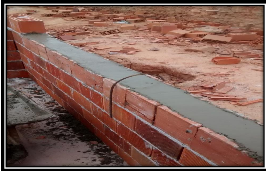
FIGURA 27. Contraverga preenchida com concreto
