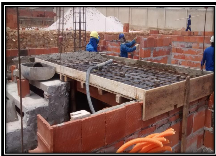
FIGURA 31. Concretagem de patamar em escada
