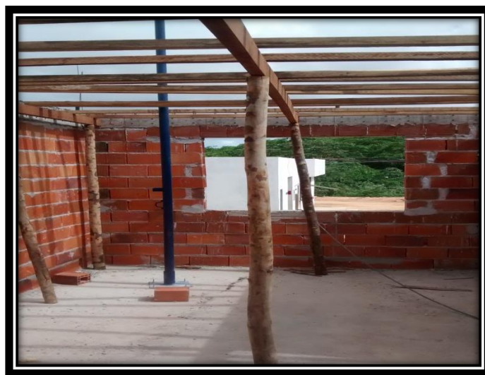
FIGURA 36. Estroncas, peças de madeira e barrotes associados.
