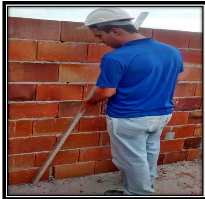
FIGURA 20. Conferência de parede com sarrafo
