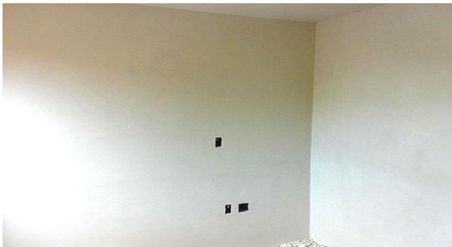
Figura 5- Revestimento de pasta de gesso corrido
