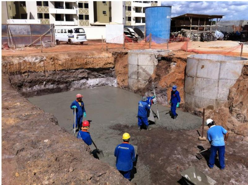
Figura 3.3 -Concretagem
