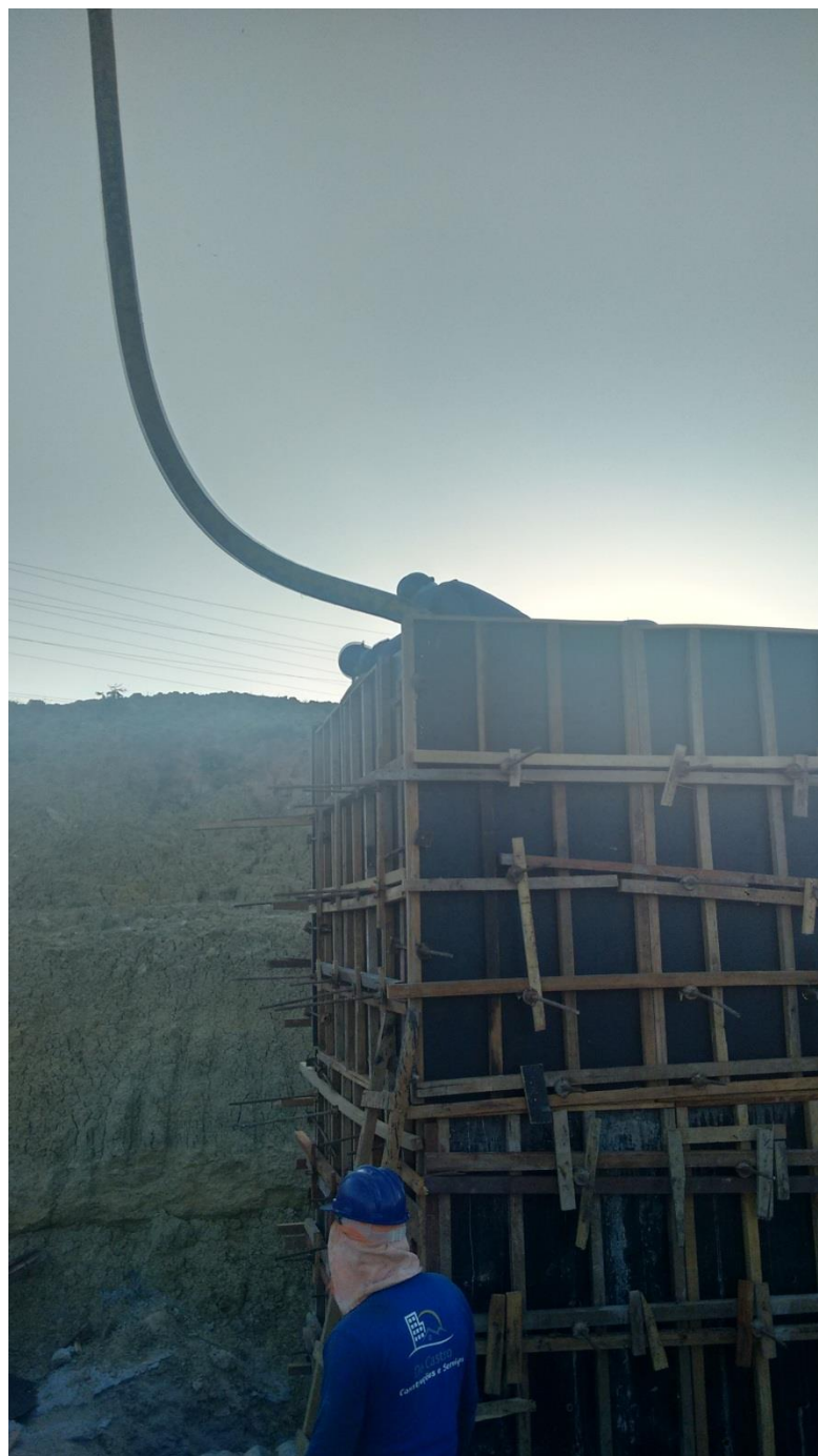
CX 03- Concretagem das paredes (2º lance).
