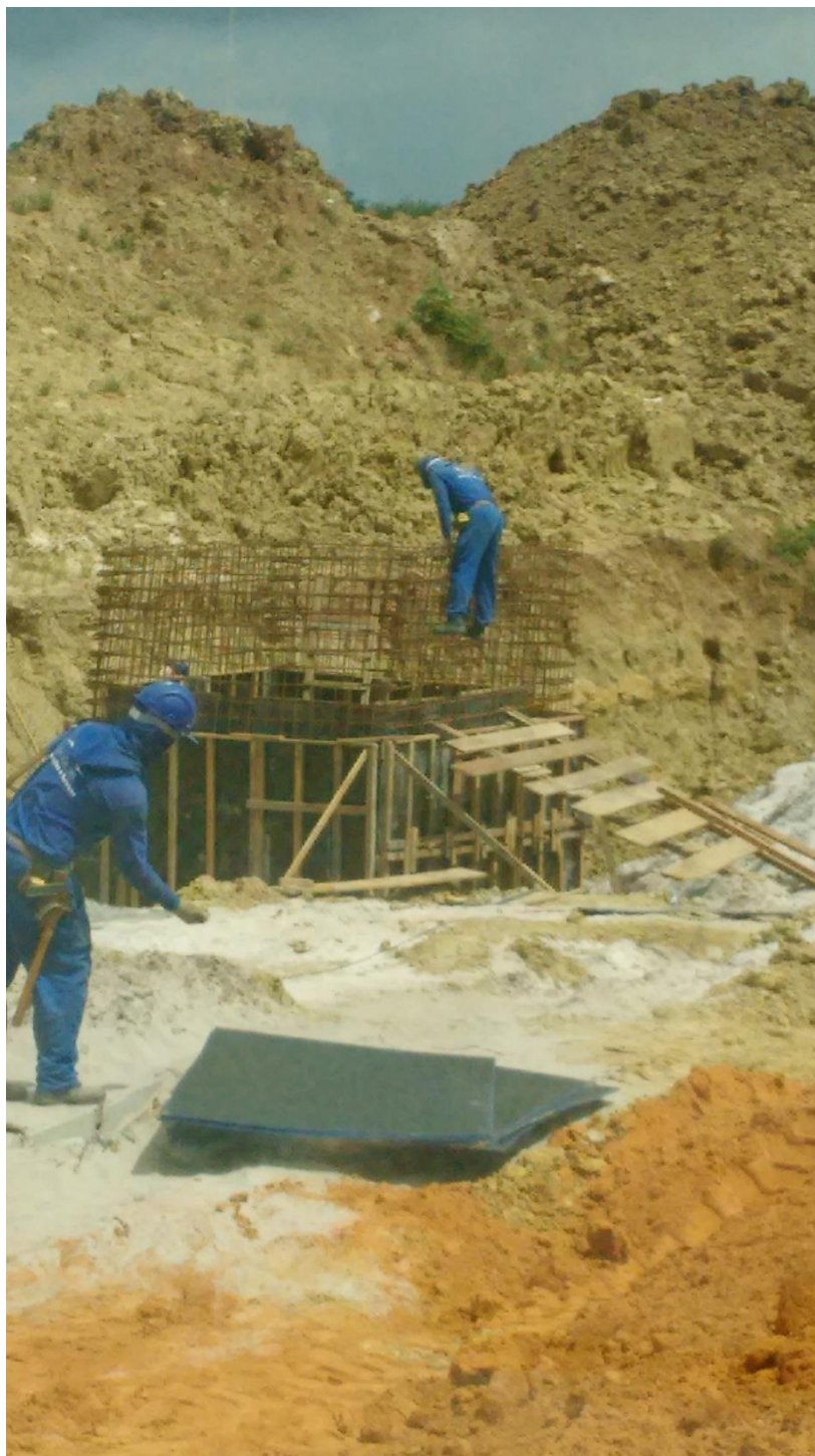
CX 03- Montagem das formas das paredes (2º lance).
