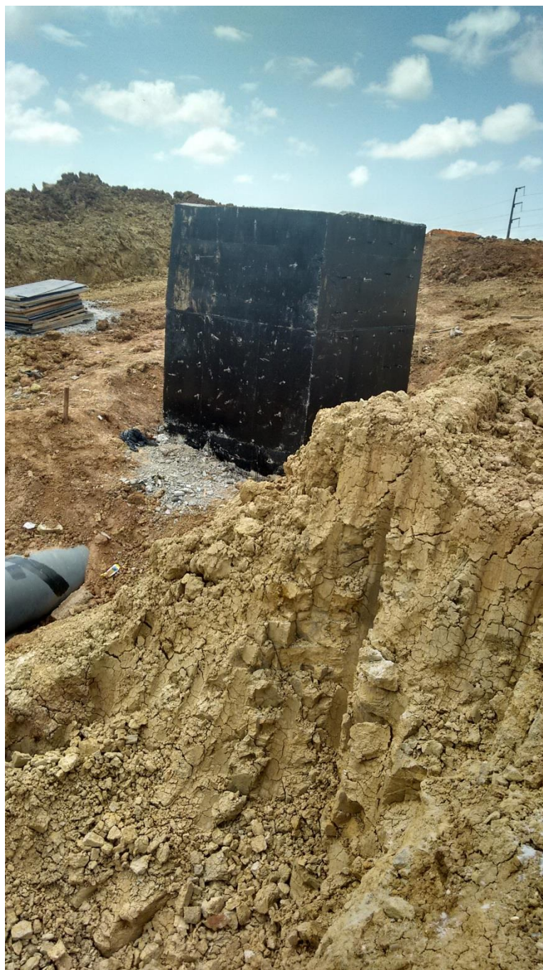
CX 01- Desforma e impermeabilização das paredes (2º lance).
