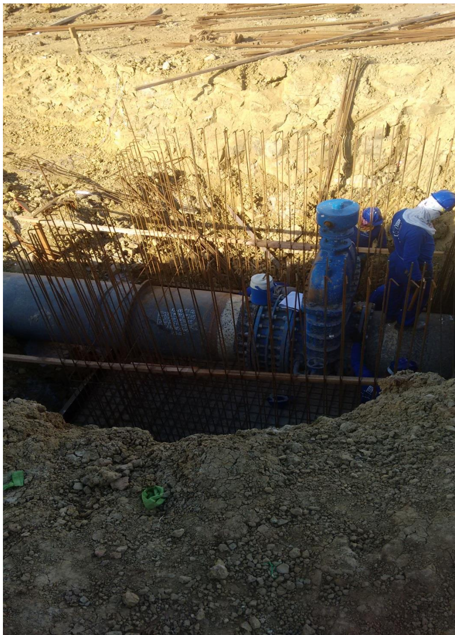
CX01- Ferragem da laje de fundo.
