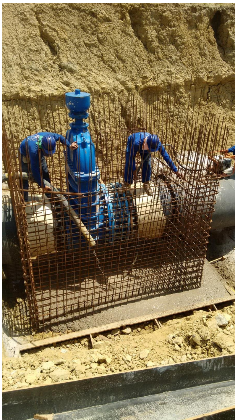
CX 03- Concretagem da laje de fundo.
