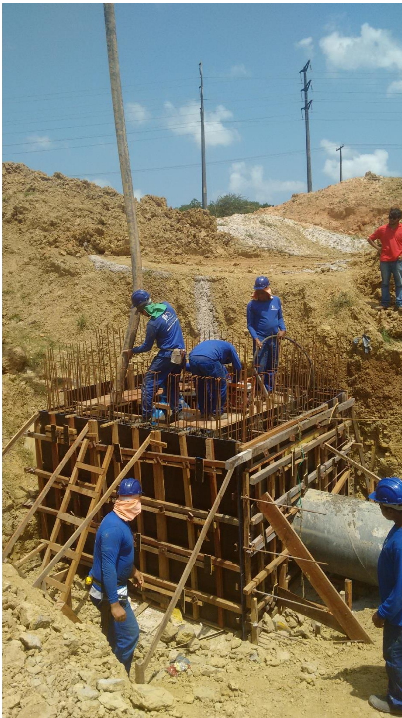
CX 01- Concretagem das paredes (1º lance).
