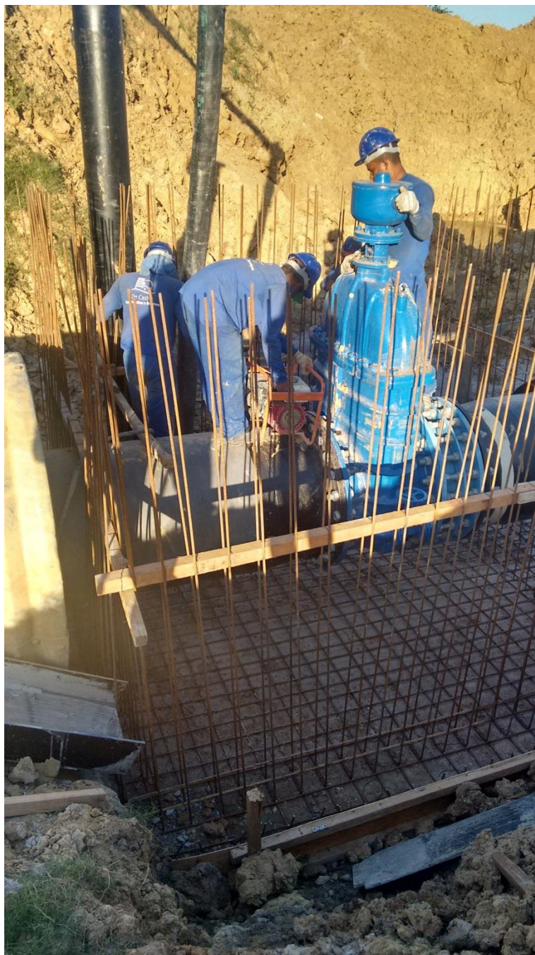
CX 02- Concretagem da laje de fundo.
