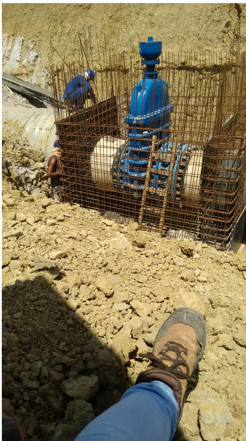
CX 03- Montagem das formas das paredes (1º lance).
