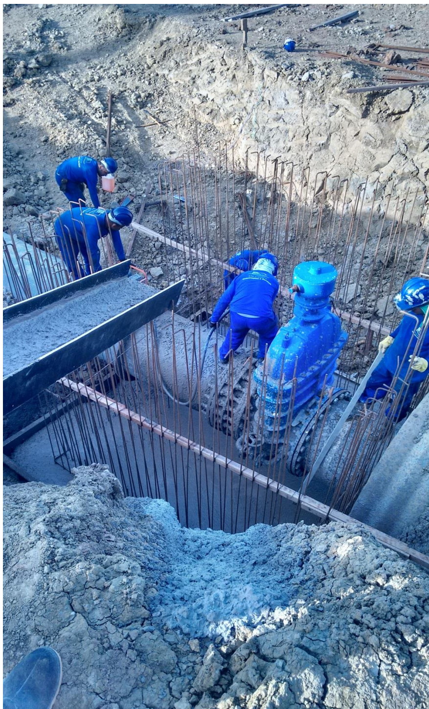
CX 01- Concretagem da laje de fundo.
