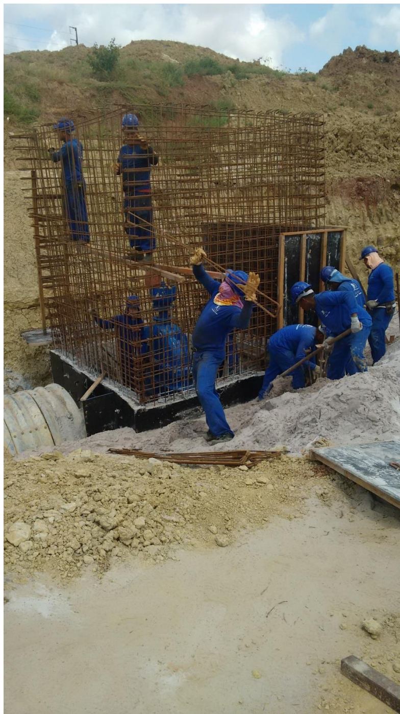
CX 03- Ferragem das paredes (2º lance).
