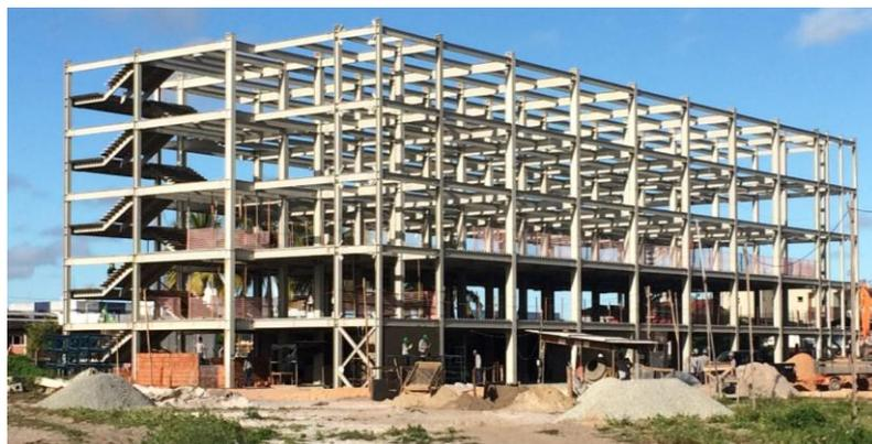
**Figura 13 – Montagem de perfis metálicos horizontais e diagonais**
