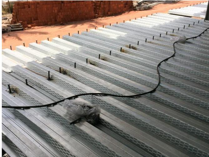
**Figura 15 – Aplicação stud bolt sobre o steel deck**
