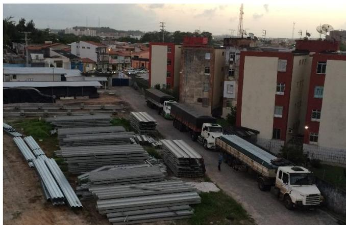
**Figura 04 – armazenamento dos perfis metálicos**
