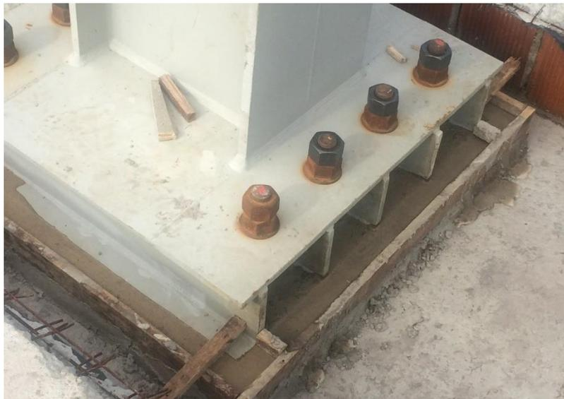
**Figura 10 – Montagem de arruelas, porcas, contra porcas e grouteamento da base**
