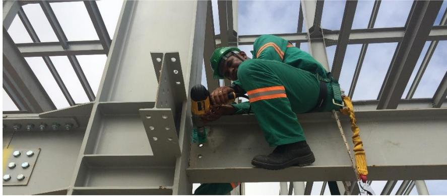
**Figura 12 – Montagem completa dos perfis e aperto final**
