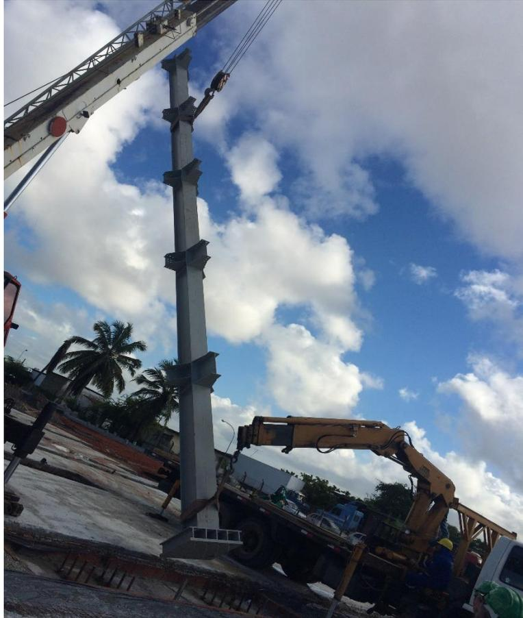
**Figura 09 – Içamento do pilar para base de fundação**
