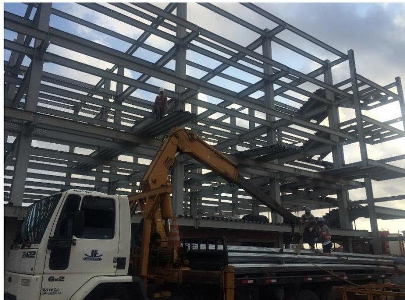
**Figura 14 – Içamento Steel deck para as lajes.**
