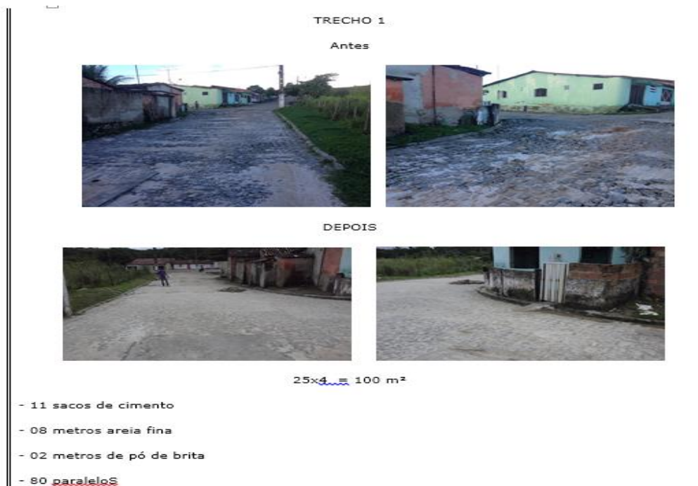
Figura 2: Anexos de fotos dos serviços antes e depois de executados
