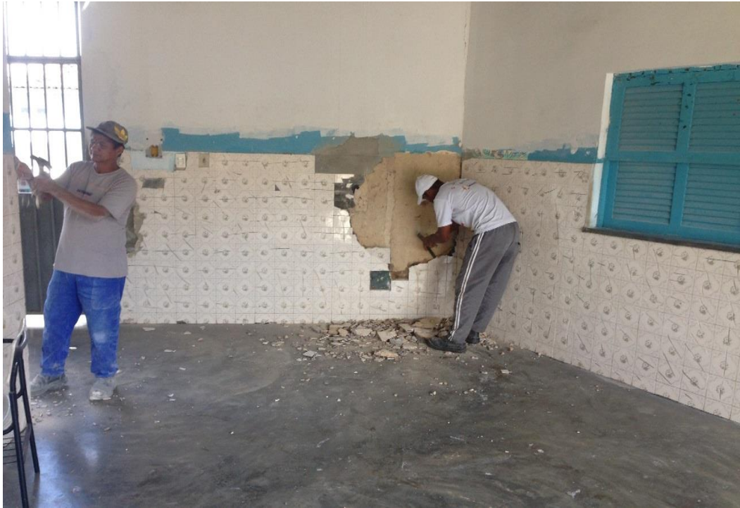
Figura 5: Retirada do revestimento cerâmico e reboco
