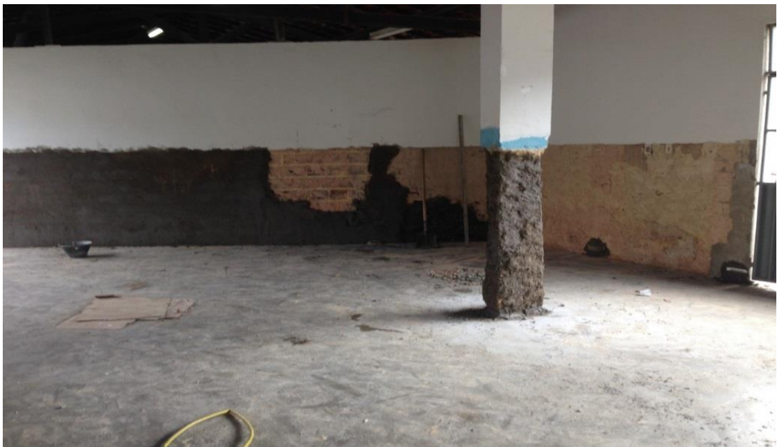
Figura 6: Rebocando parede
