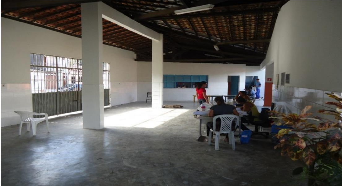
Figura 7: Parede já revestida com cerâmica
