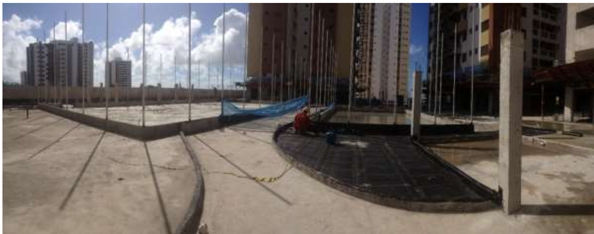
Figura 01: Aplicação de manta asfáltica.
