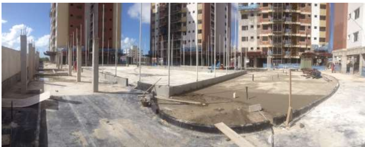
Figura 02: Proteção mecânica sobre a manta asfáltica.
