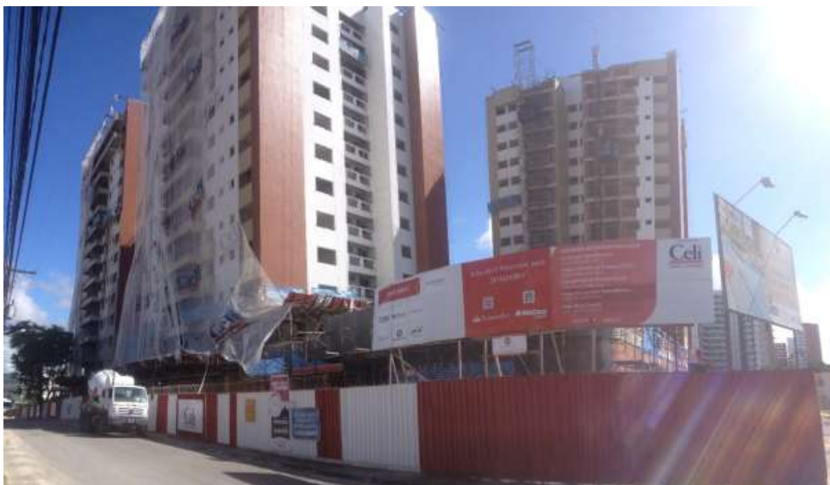
Figura 01: Visão frontal do canteiro de obras.
