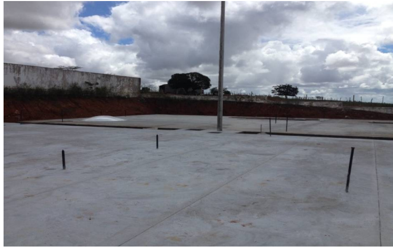
Figura 5: Pavimentação piso em concreto
