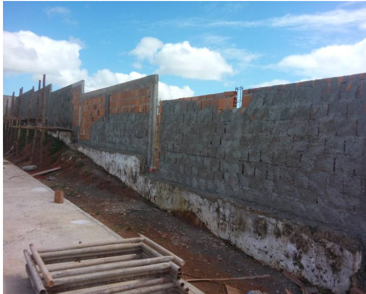
Figura 15: Muro em construção
