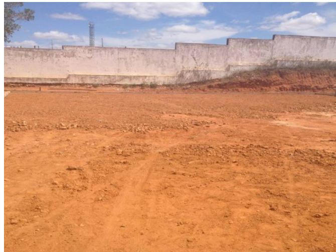
Figura 2: Regularização do terreno
