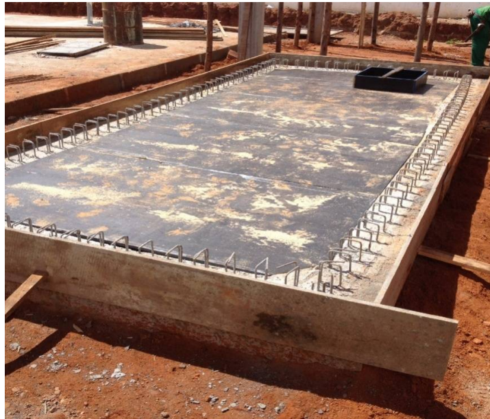
Figura 8: Pavimentação piso em concreto
