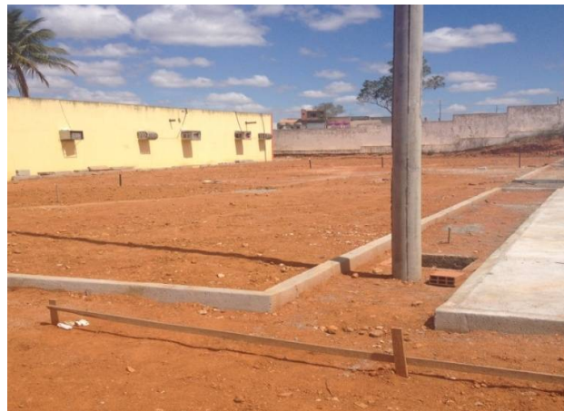
Figura 3: Demarcação com meio-fio
