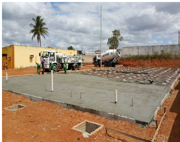
Foto 4: Execução da pavimentação em concreto
