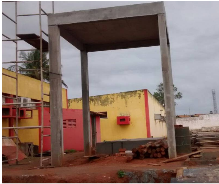
Figura 9: Base em concreto para reservatório superior
