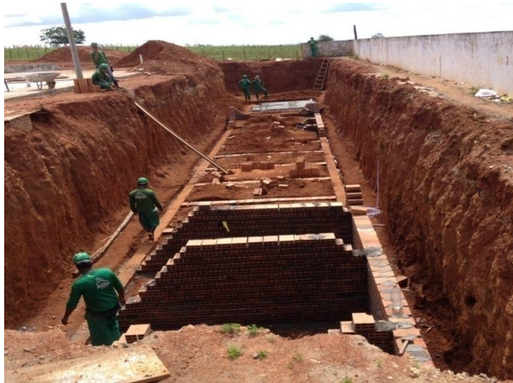
Figura 12: Execução do filtro e sumidouro
