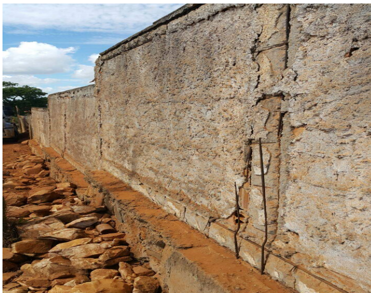
Foto 14: Muro antes da demolição
