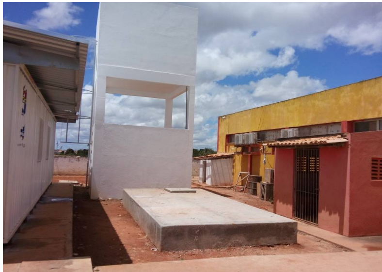
Figura 10: Reservatório inferior e superior
