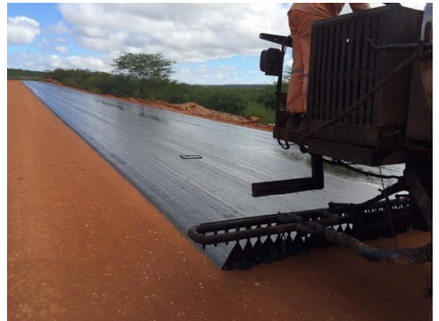
Figura 23: Imprimação da base
