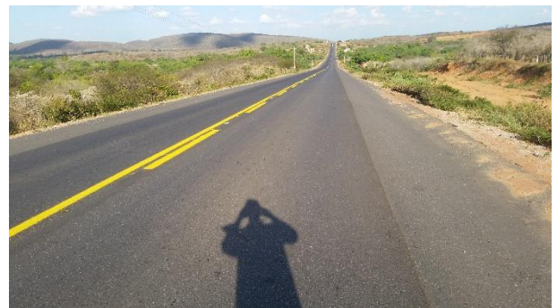
Figura 27: Capa de rolamento com Eixo sinalizado
