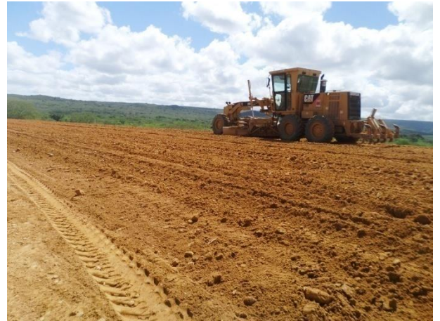
Figura 13: Regularização do sub leito
