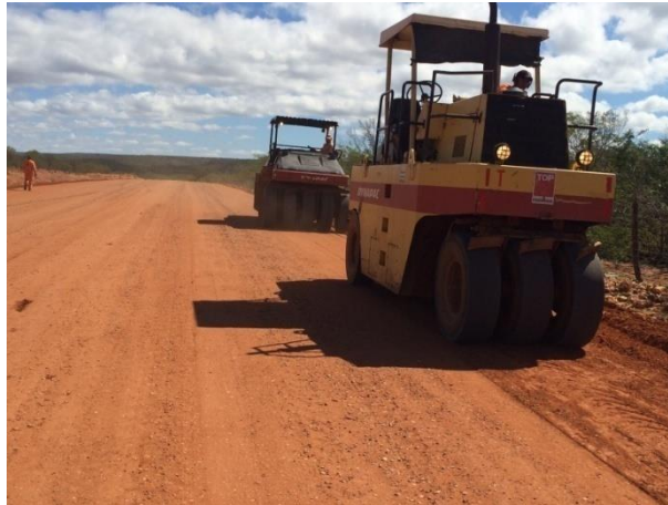
Figura 3: Execução da camada de Base
