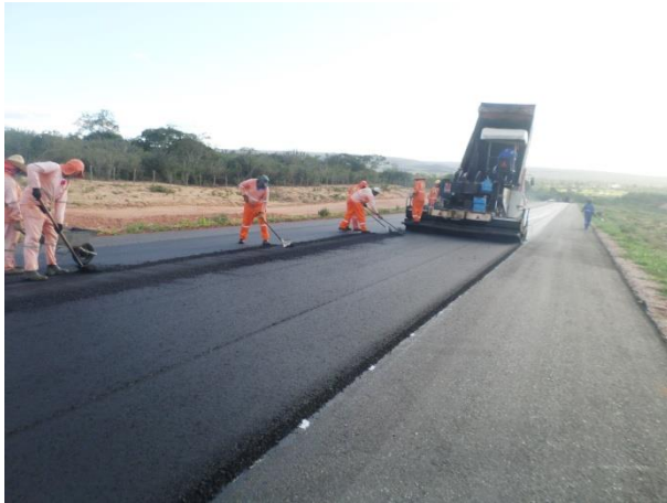
Figura 24:Primeira camada asfáltica (Binder)
