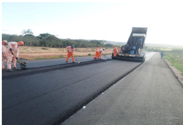
Figura 6: Execução da capa de rolamento sobre o binder
