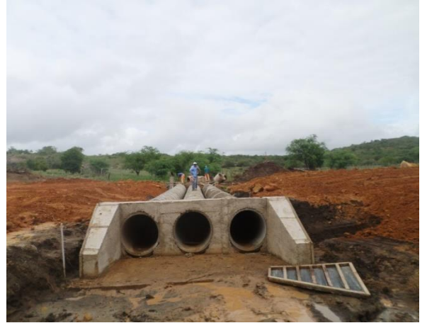
Figura 17: Execução de Bueiro Tubular Triplo
