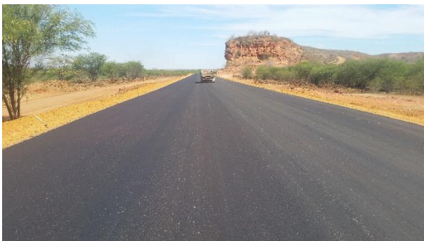
Figura 26: Capa de rolamento executada
