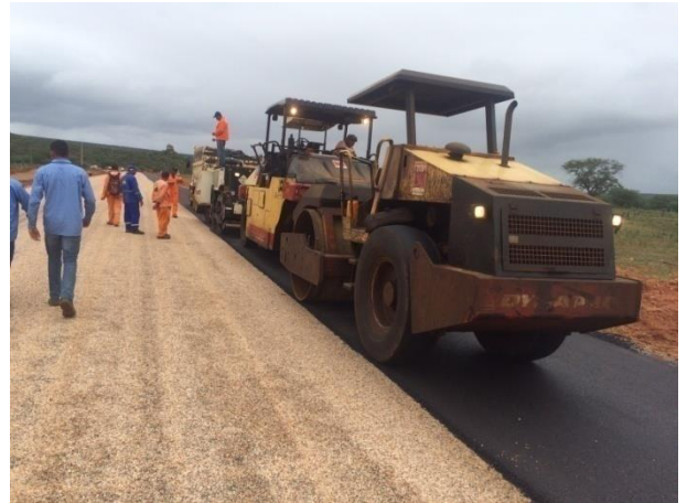
Figura 25: Segunda camada asfáltica (Camada de rolamento)
