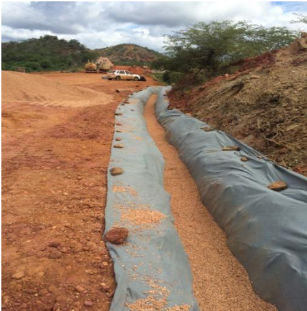
Figura 18: Execução de drenagem profunda
