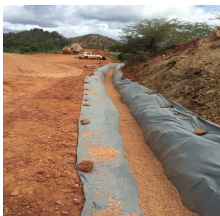
Figura 9: Execução de drenagem
