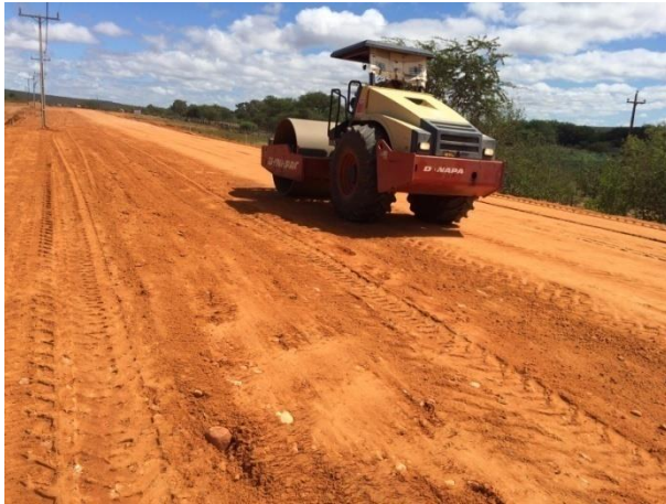
Figura 12: Execução de terraplanagem
