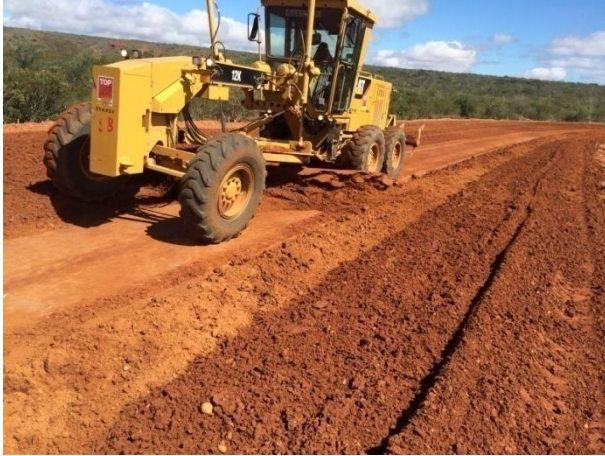
Figura 20: Execução da camada de base
