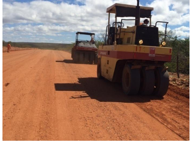
Figura 21: Execução da camada de base
