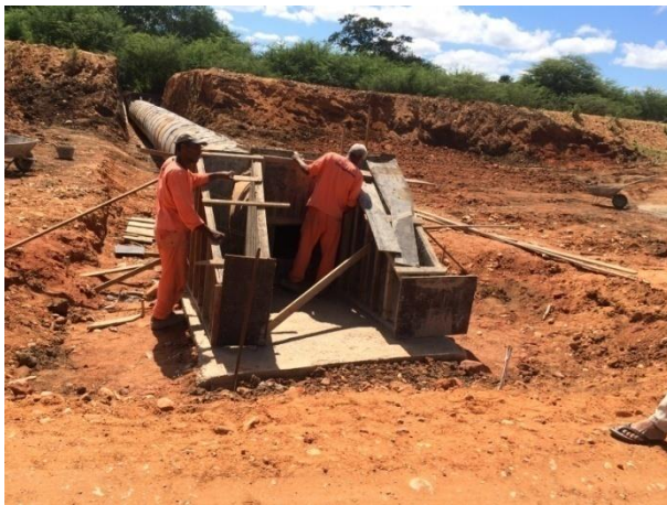
Figura 14: Execução de Bueiro Tubular Simples
