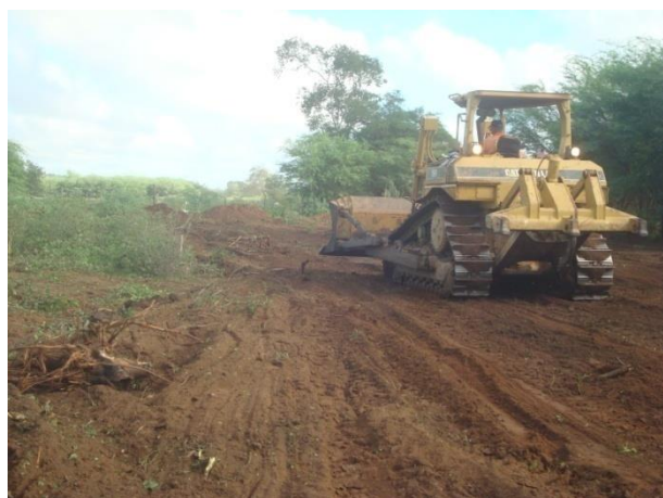
Figura 11: Execução de Desmatamento
