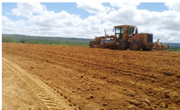
Figura 1 : Execução de Terraplanagem
