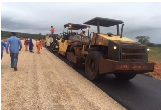
Figura 5: Execução do Binder sobre camada de (TSS)
