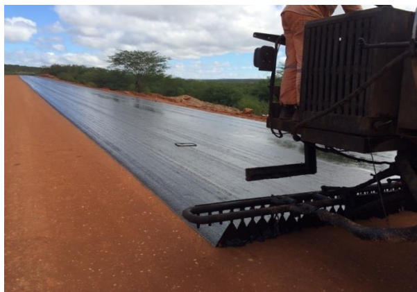
Figura 4: Imprimação da Base
