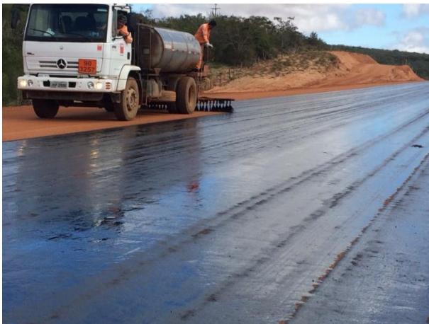
Figura 22: Imprimação da base
