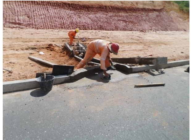
Figura 19: Execução de Descida d'água
