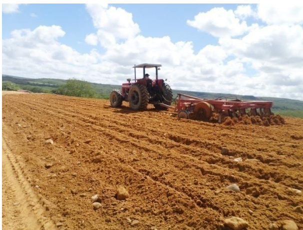
Figura 10: Execução de Terraplanagem
