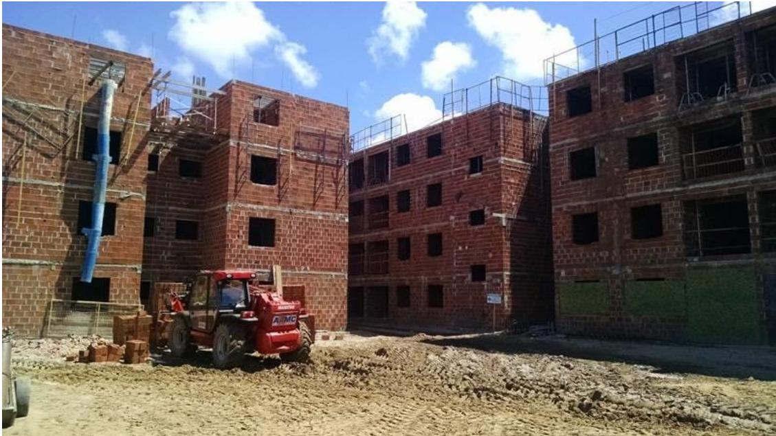
Foto 3 – Manipulador Telescópico abastecendo o Bloco 8 – 4º pavimento
