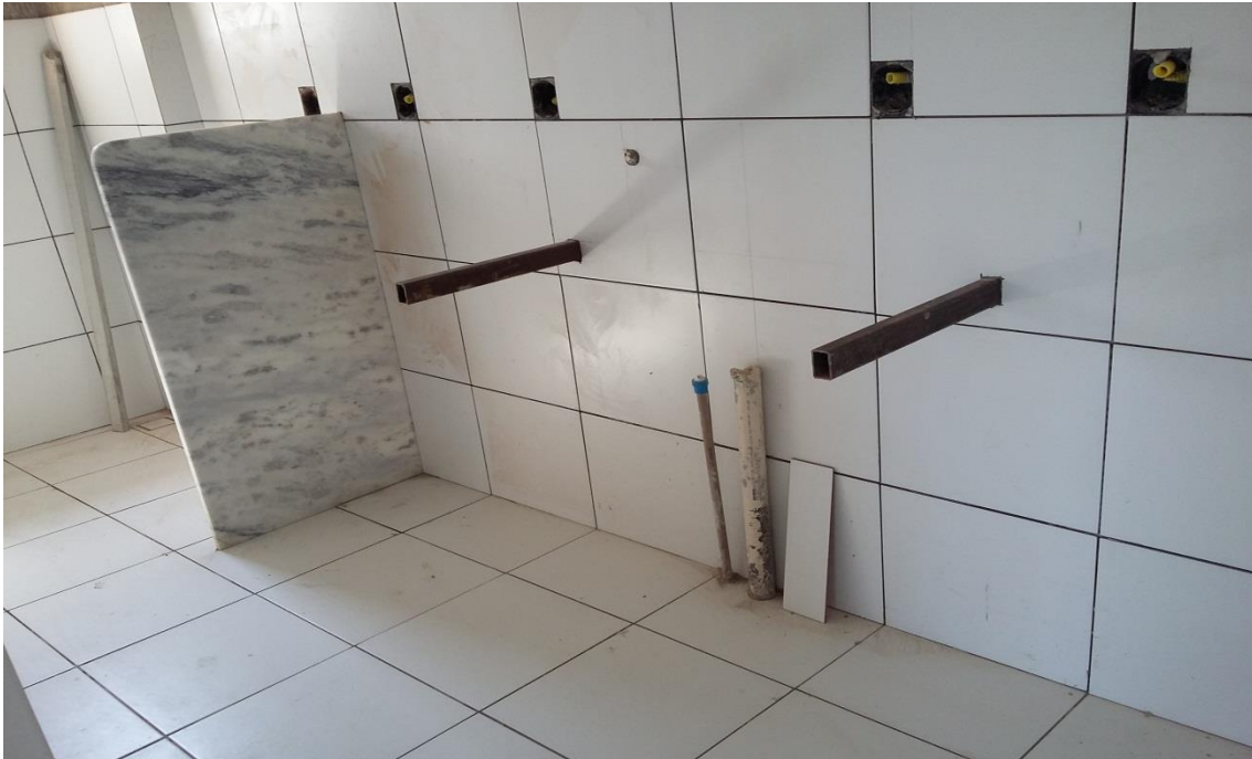
Foto 5: Revestimento cerâmico na cozinha
