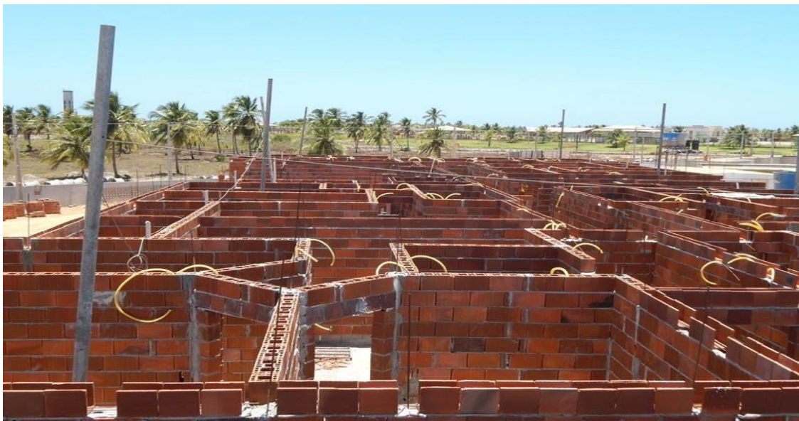
Foto 2 – Execução da alvenaria estrutural do 2º Pavimento Bloco 10
