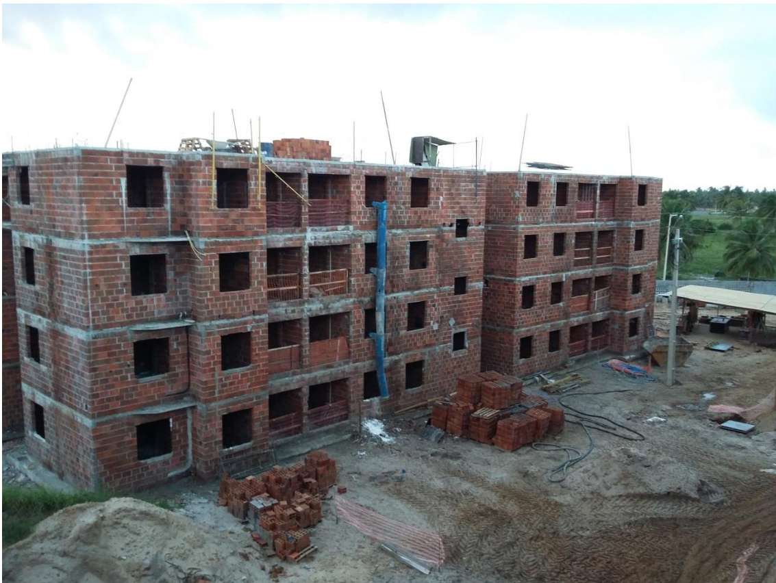
Foto 4: Alvenaria Finalizada do Bloco 11
