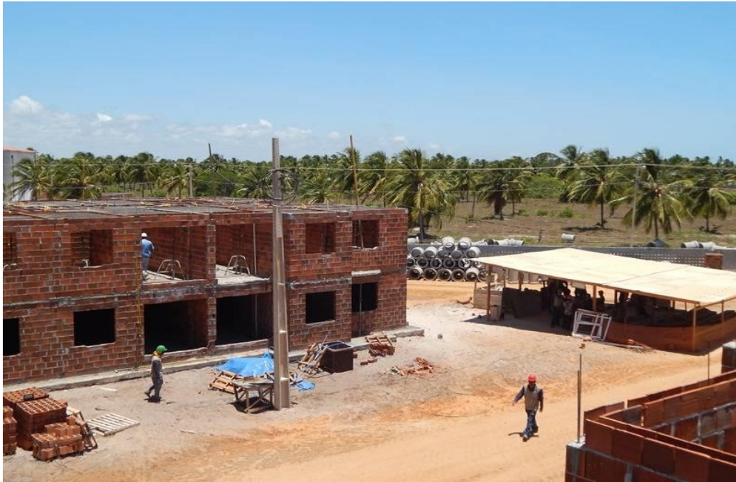
Foto 1 – Execução da forma para concretagem da 2ª laje – Bloco 11
