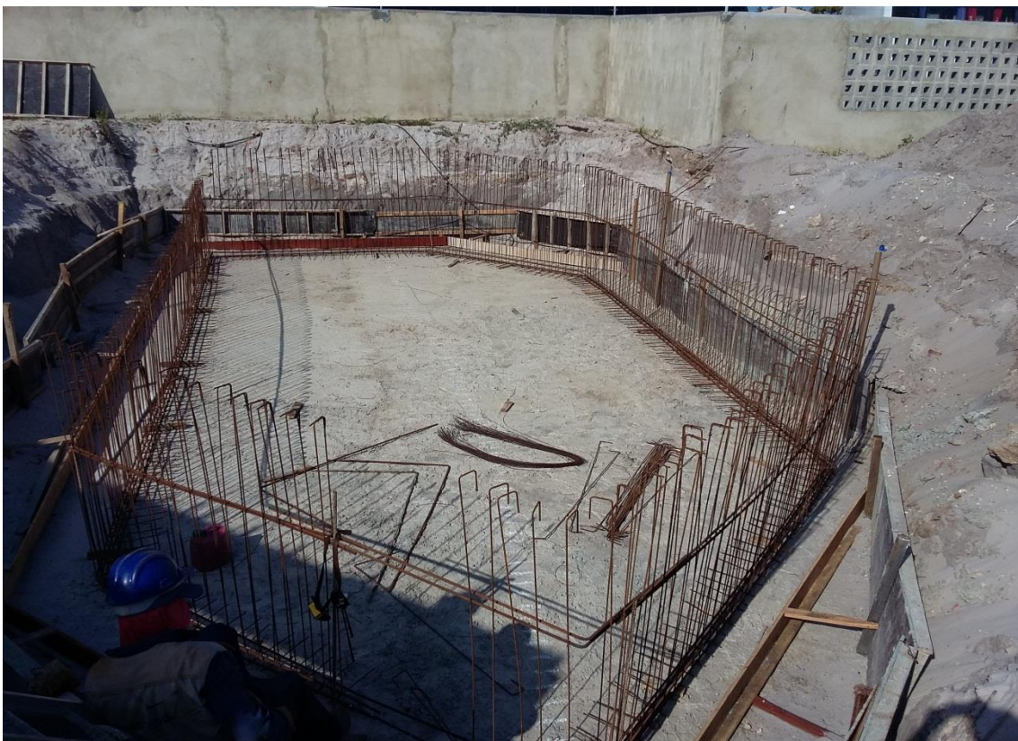
Foto 6 : Execução da piscina
