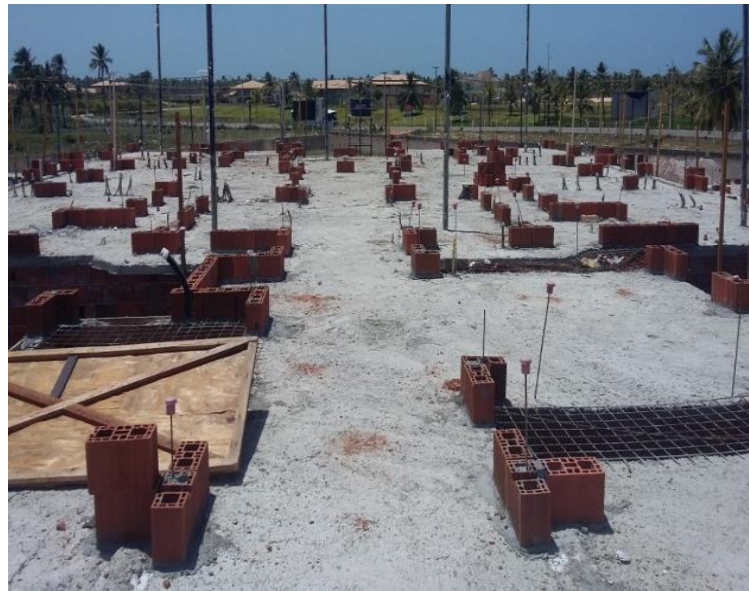
Marcação da Alvenaria
