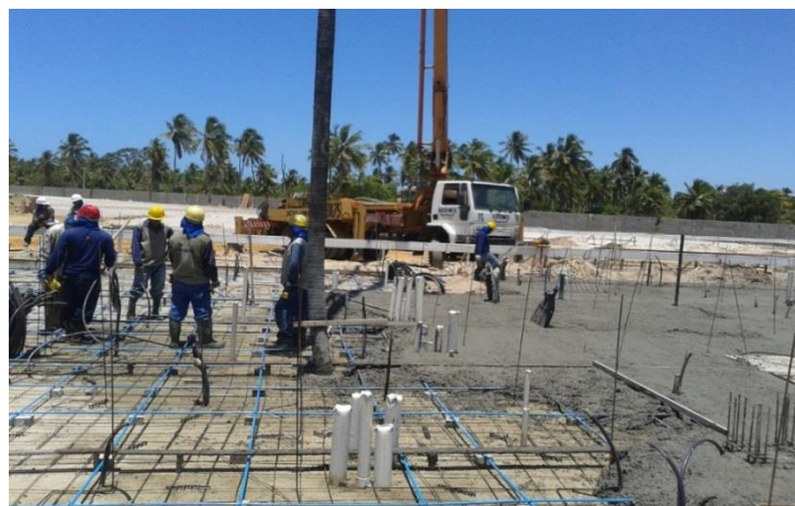
Concretagem do Radier
